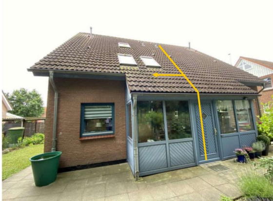
Nordansicht (Haushälfte markiert)
