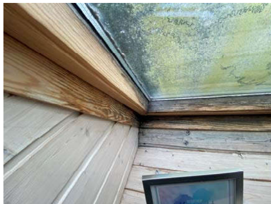
Schadhaftes Dachflächenfenster
