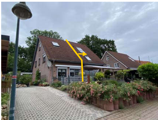
Straßenansicht, Südwesten (Haushälfte markiert)
