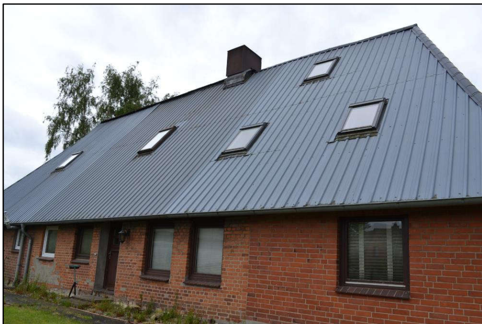
Bild 12: etwa Ostnordostansicht des Gebäudes
