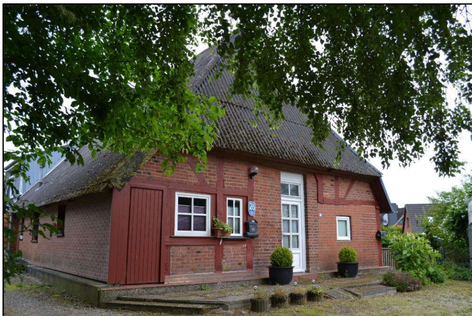
Bild 6: etwa Südsüdwestansicht des Gebäudes
