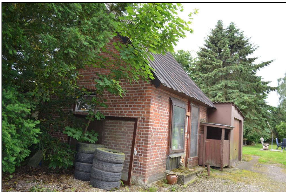
Bild 24: etwa Nordostansicht des Nebengebäudes mit Garage
