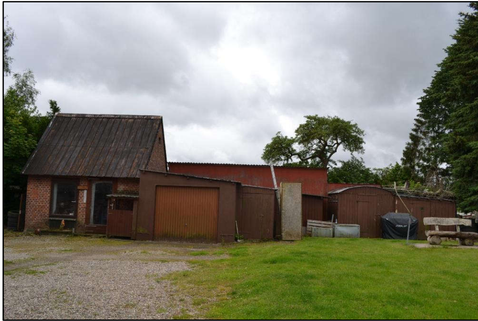
Bild 21: etwa Nordnordostansicht des Nebengebäudes mit Garage und Schuppen an der Südsüdwestgrenze
