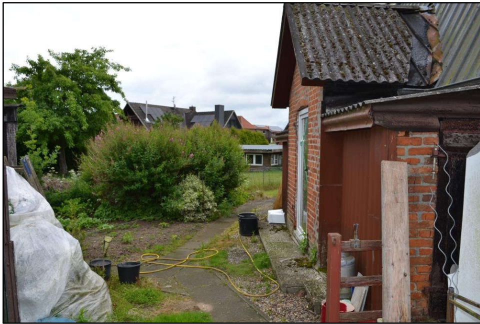
Bild 15: Blick in die Grundstücksfreifläche nördlich des Gebäudes
