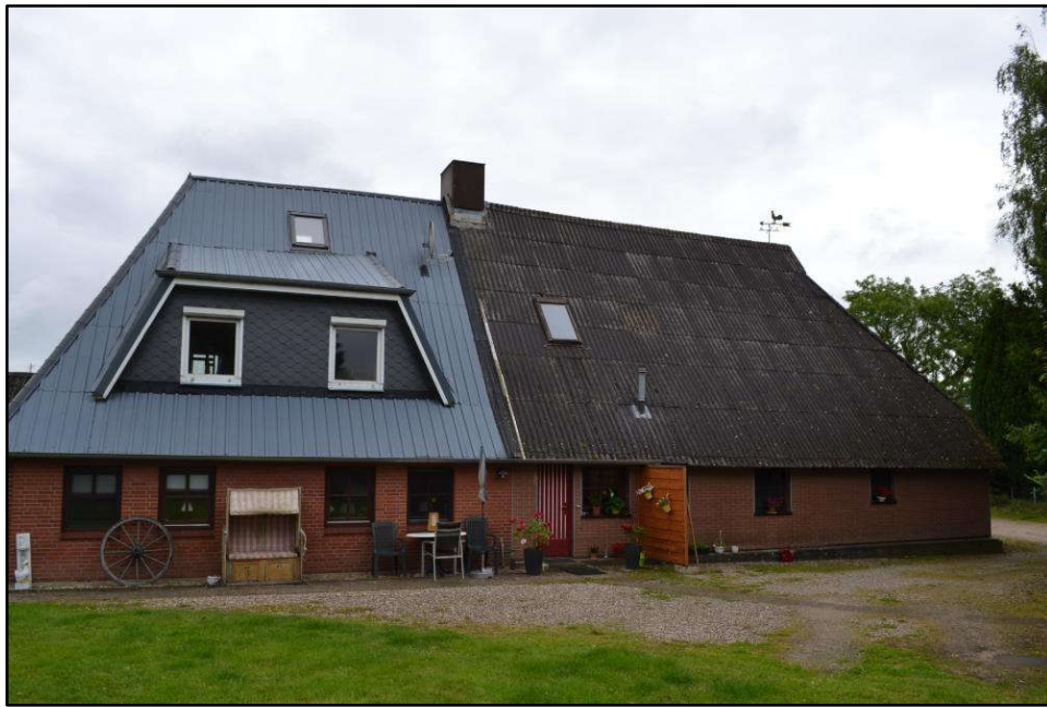
Bild 7: etwa Westsüdwestansicht des Gebäudes
