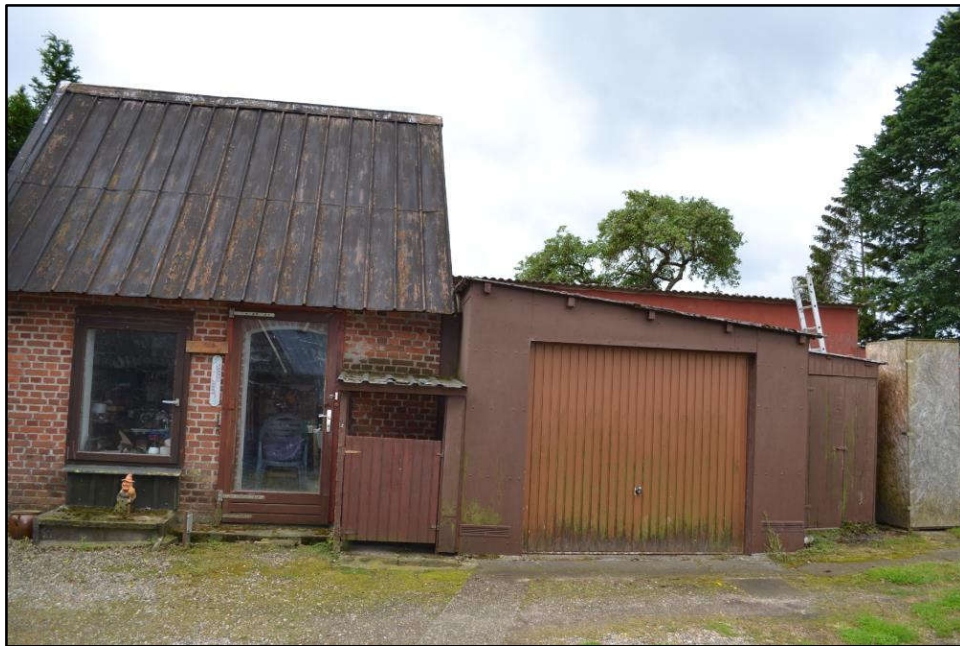
Bild 23: etwa Nordnordostansicht des Nebengebäudes mit Garage
