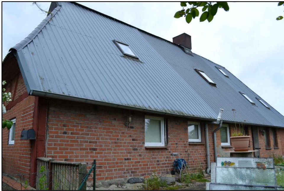
Bild 13: etwa Südostansicht des Gebäudes
