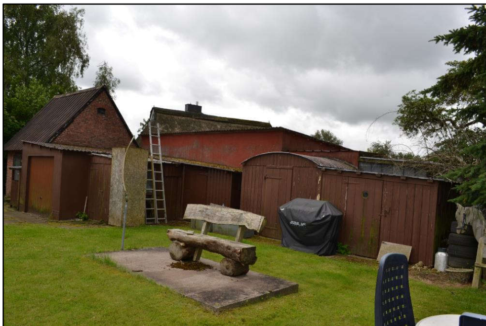
Bild 22: etwa Nordwestansicht des Nebengebäudes mit Garage und Schuppen an der Südsüdwestgrenze
