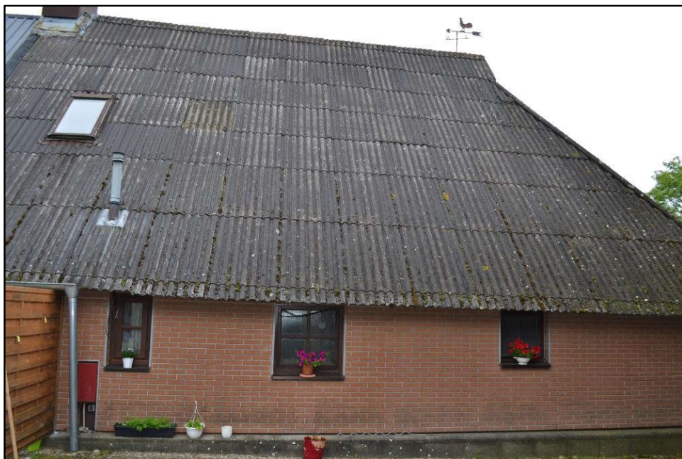
Bild 8: etwa Westsüdwestansicht des südlichen Gebäudeteils
