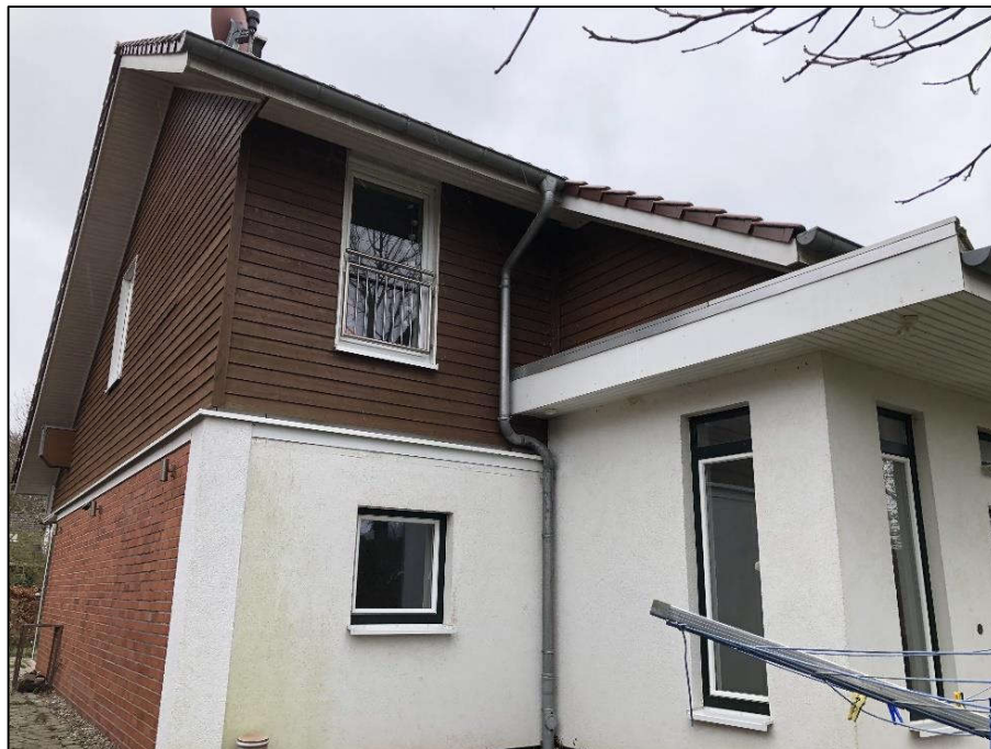
Bild 11: Nordost(teil)ansicht des Wohnhauses mit An-/Vorbau
