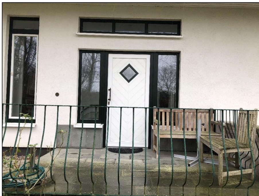
Bild 14: Hauseingangsbereich als Detailaufnahme
