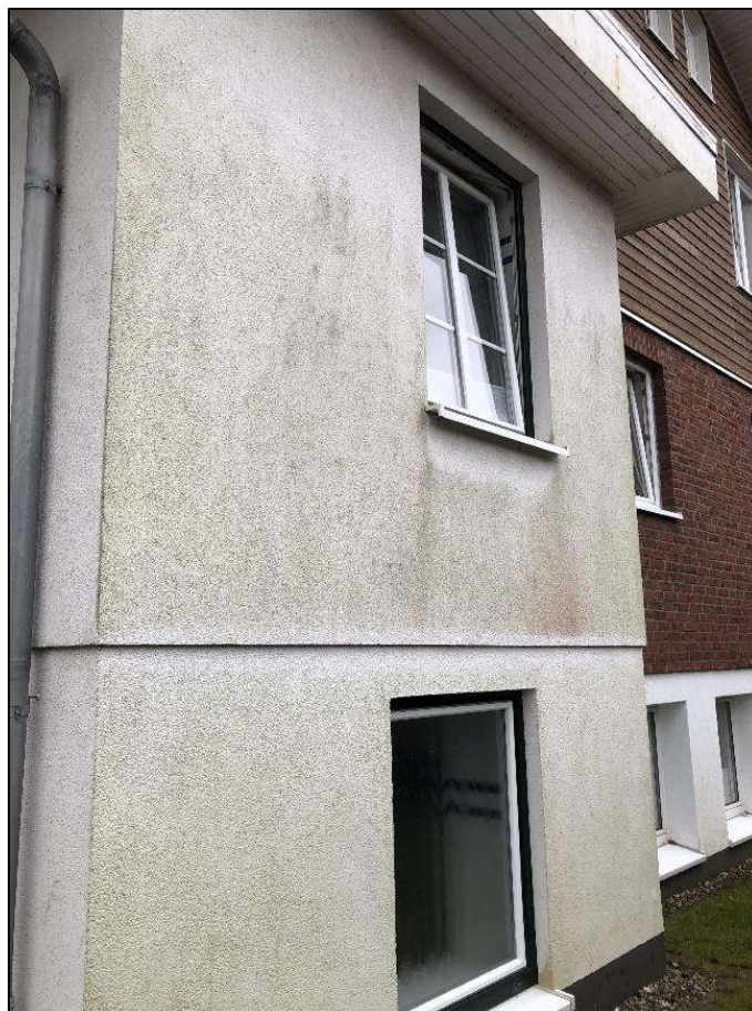
Bild 16: Westansicht des Anbaus als Detailaufnahme
