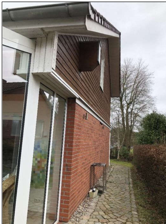
Bild 10: Giebelostansicht des Wohnhauses
