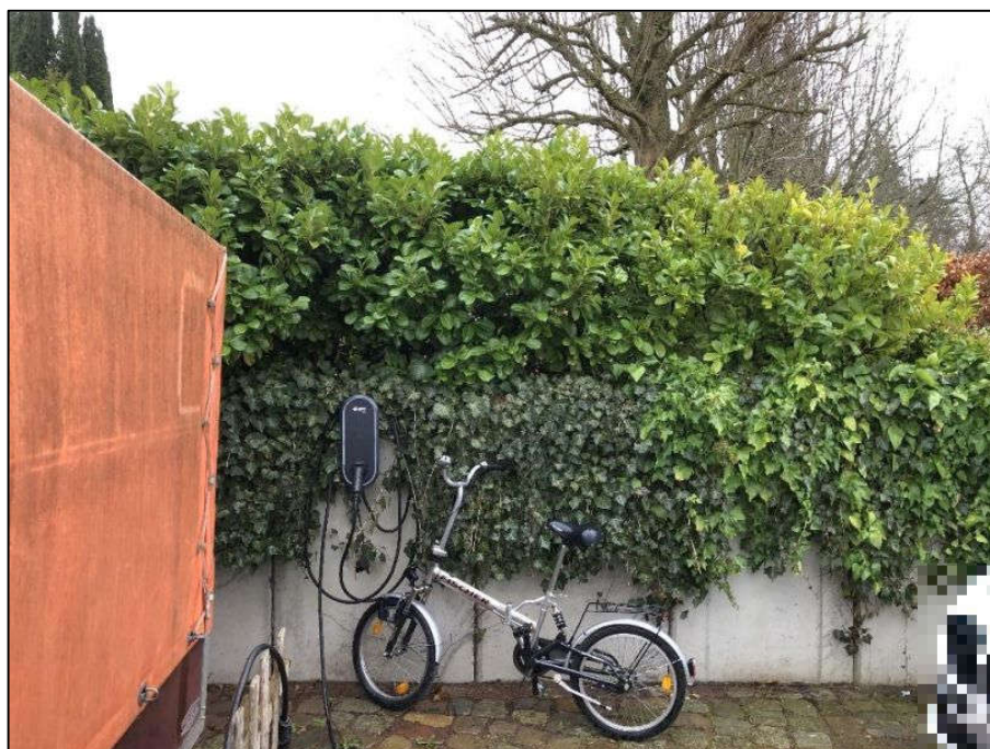
Bild 20: Westansicht der Vorgartenbegrenzung mit Betonwinkelstützelementen
