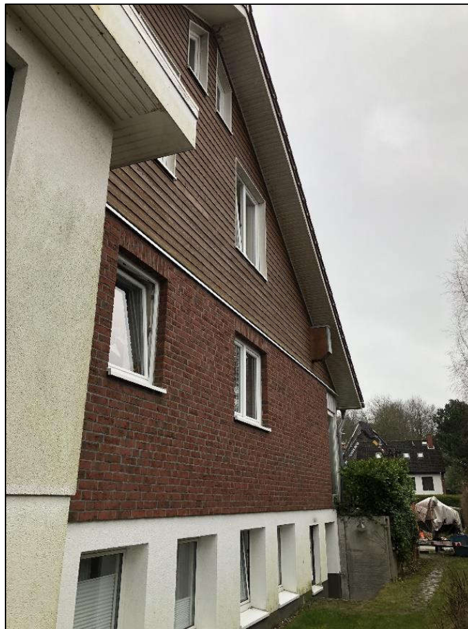
Giebelwestansicht des Wohnhauses mit Kellerfenstern über Gelände
