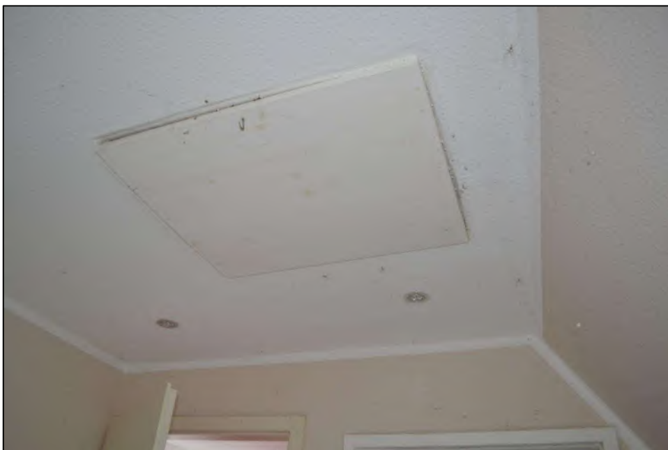
Bild 48: Bodenluke (Flur) zum verbleibenden Spitzbodenraum
