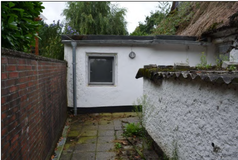
Bild 25: Rückansicht des Vorbaus auf der Südseite
