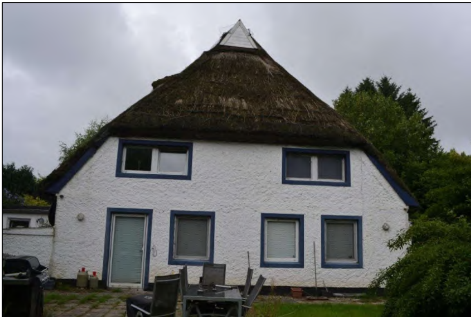
Bild 21: Ostnordostansicht des Gebäudes
