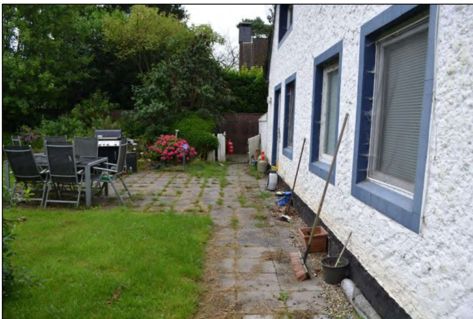
Bild 20: Blick entlang der Gebäudeostseite
