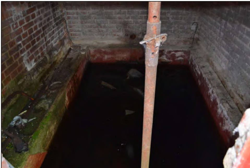
Bild 27: Blick in den Anbau (ehem. Öltanklager)
