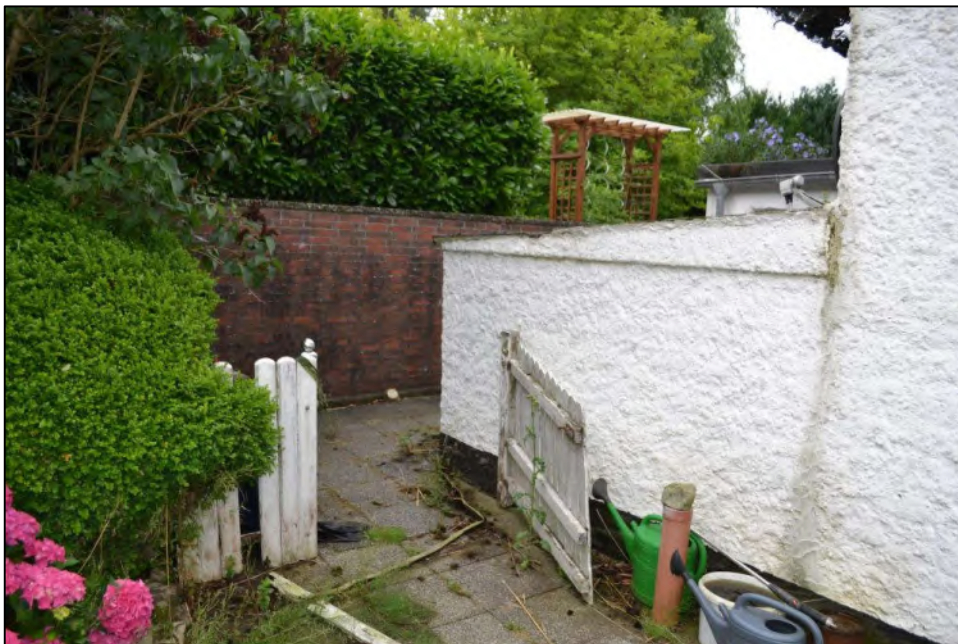
Bild 22: Zugang zur hinteren Gebäudesüdseite
