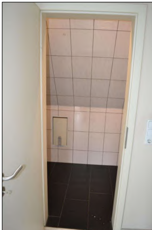
Bild 42: Tür zum Duschbad/WC (Südseite)
