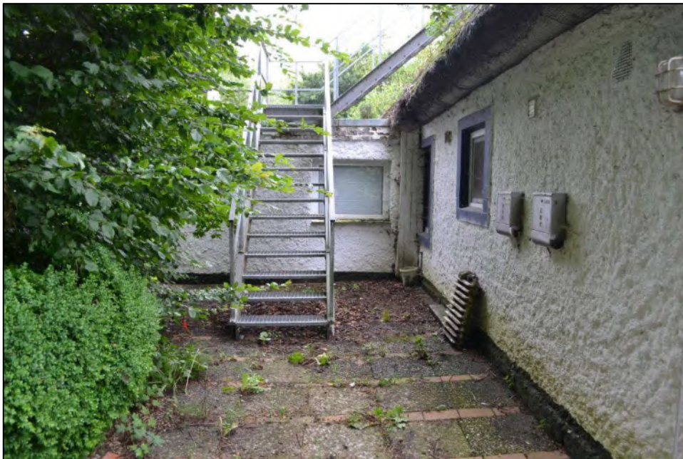
Bild 17: Rückansicht des Vorbaus auf der Nordseite mit Treppenaufgang zum Spitzboden
