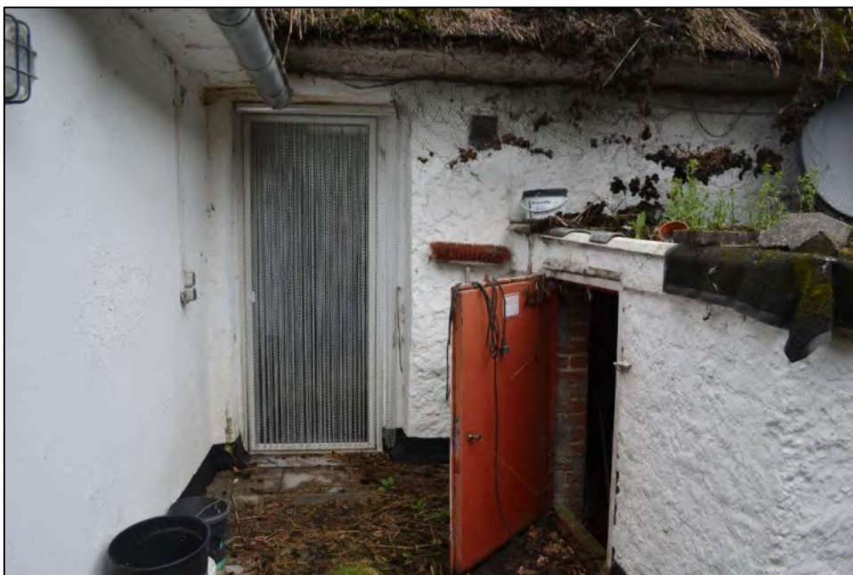
Bild 26: Nebentür und Luke zum Anbau (ehem. Öltanklager)
