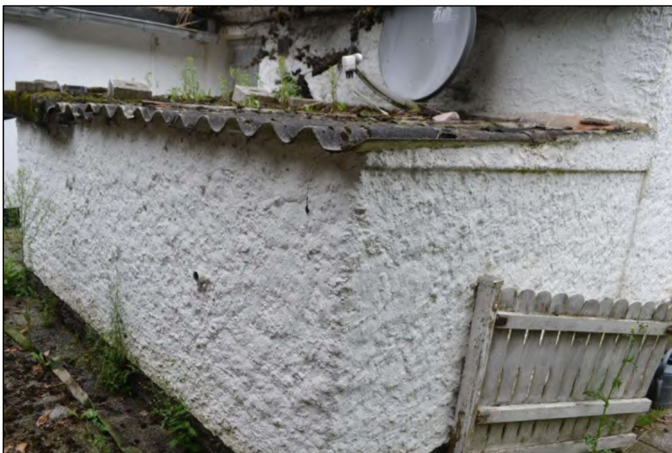
Bild 24: Südostansicht eines Anbaus (ehem. Öltanklager)
