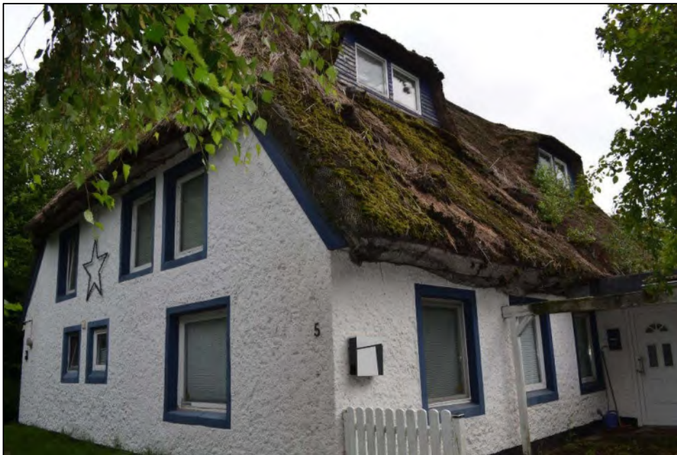
Bild 13: Südwestansicht des Gebäudes
