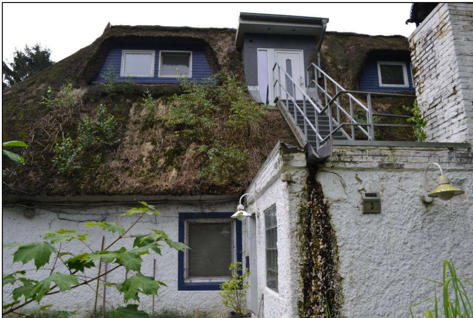
Bild 11: Nordnordwestansicht des Gebäudes
