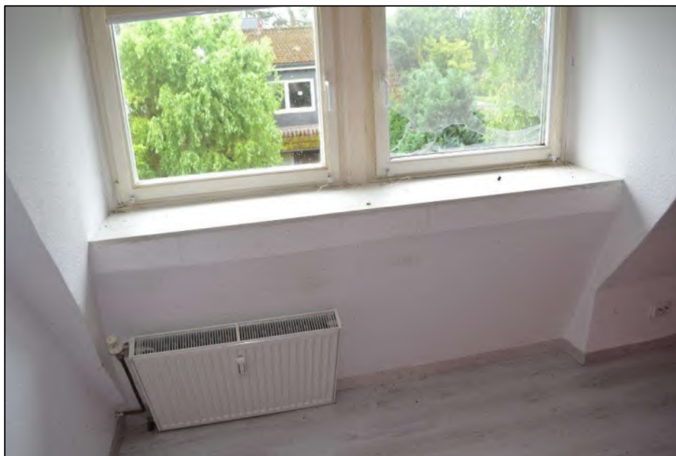
Bild 46: Gaubenfenster auf der Südseite
