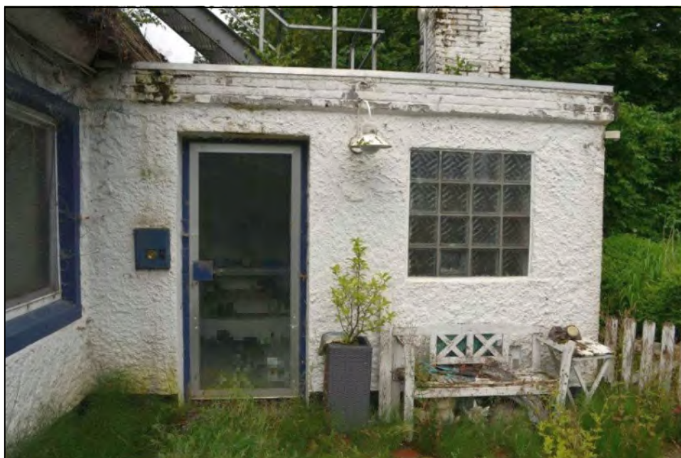
Bild 12: Vorbau auf der Nordseite mit Eingangstür (Seestraße 3)
