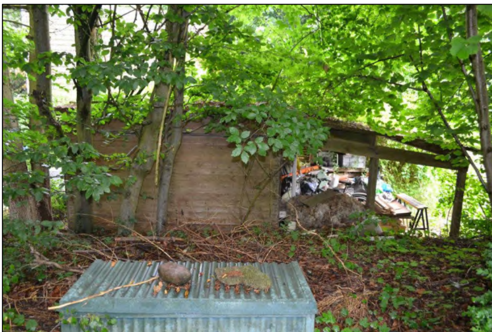
Bild 16: Nordansicht des Unterstands/Schuppens (siehe Bild 9)
