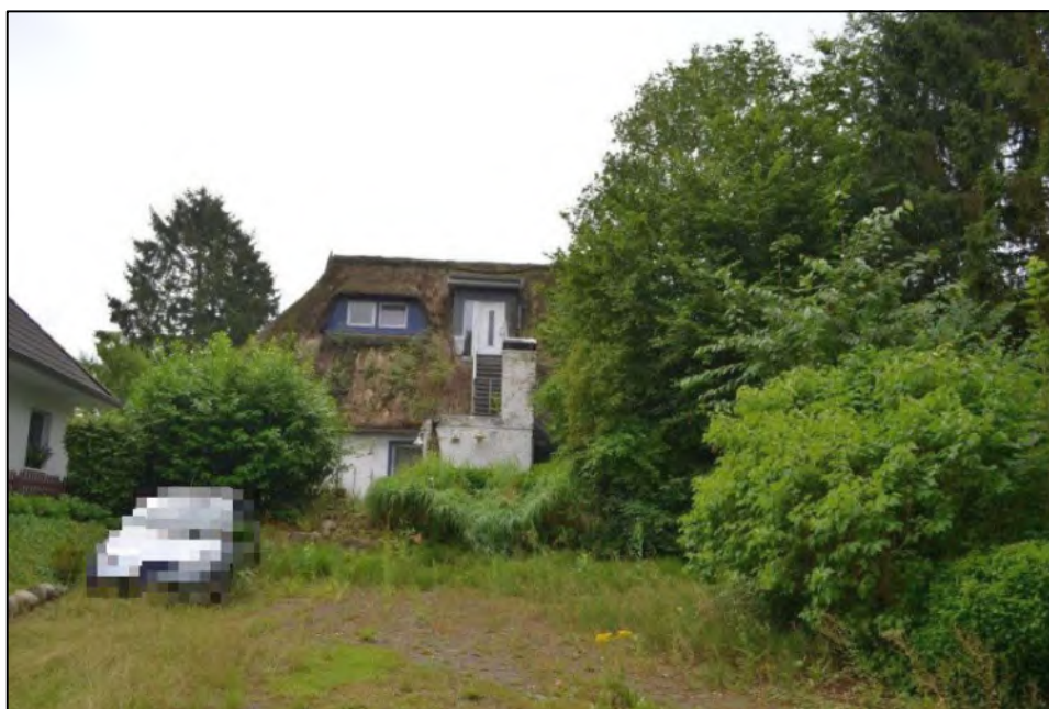
Bild 8: Nordnordwest des Grundstücks/des Gebäudes mit Stellplätzen
