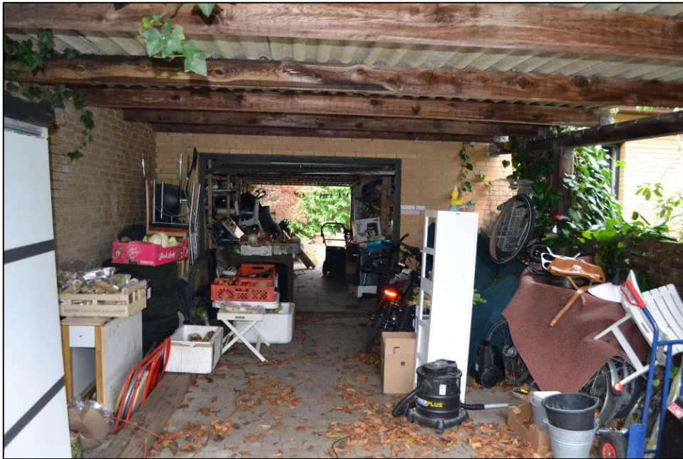
Bild 15: Blick in den Carport zur Garage
