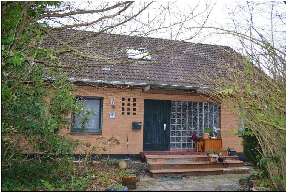
Bild 7: Ostansicht des Wohnhauses
