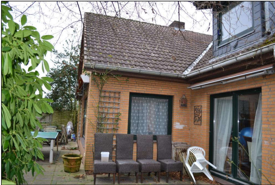
Bild 19: Süd(teil)ansicht des Wohnhauses
