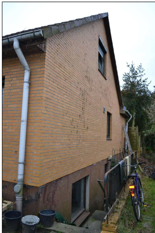
Bild 10: Giebelnordseite des Wohnhauses mit Außentreppe zum KG
