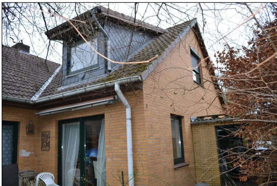
Bild 18: Südwest(teil)ansicht des Wohnhauses
