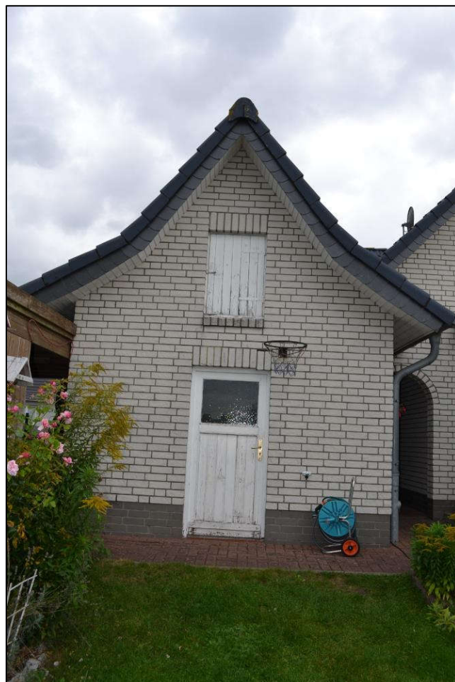
Bild 18: West-/Giebelansicht des ehemaligen Stallanbaus mit Geräte- und Bodenraum
