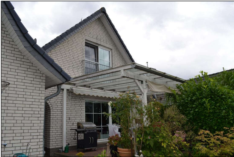
Bild 19: West-/Giebelansicht des Gebäudes mit Terrassenüberdachung
