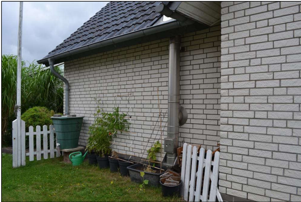
Bild 15: Trauf-/Südseite des Gebäudes mit Edelstahl-Außenschornstein
