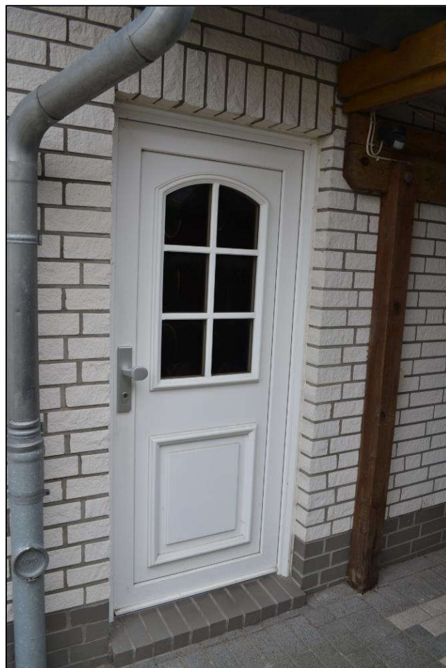
Bild 10: Außen-/Nebentür vom/zum HWR
