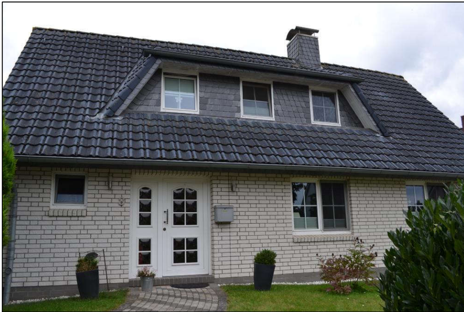
Bild 7: Ostansicht des Gebäudes
