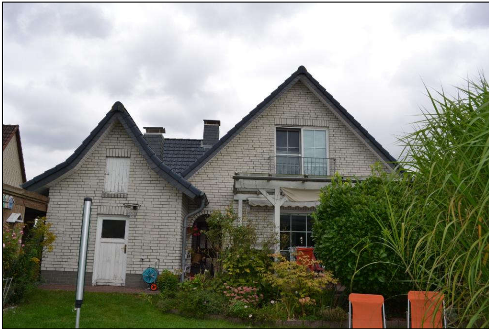
Bild 17: West-/Giebelansicht des Gebäudes
