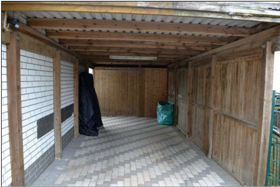
Bild 11: Vorder-/Ostansicht der Carportanlage mit Gerätekommer
