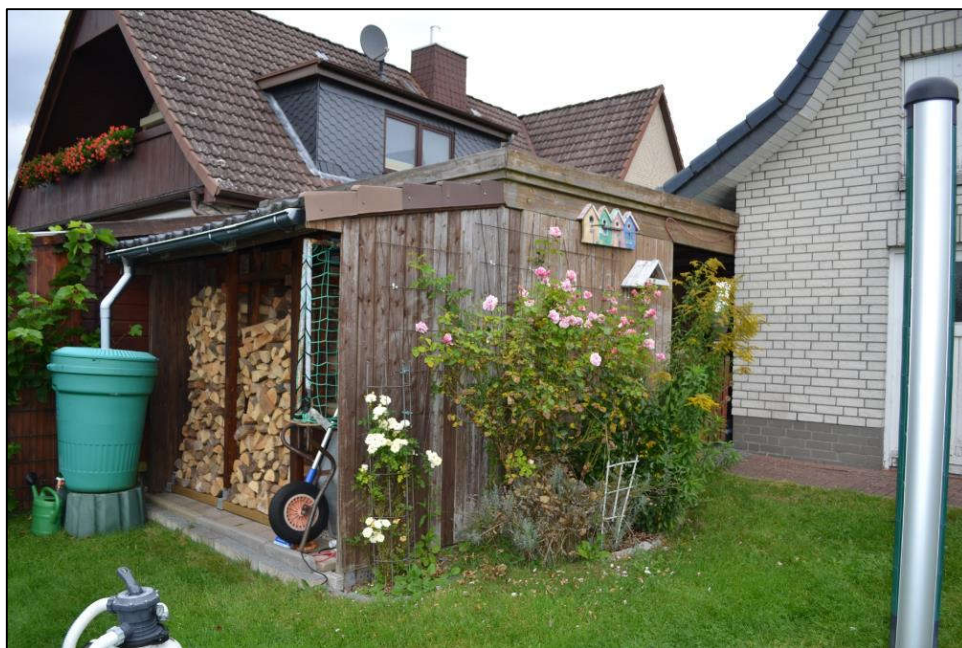
Bild 22: Südwestansicht der Carportanlage mit Geräteekammer
