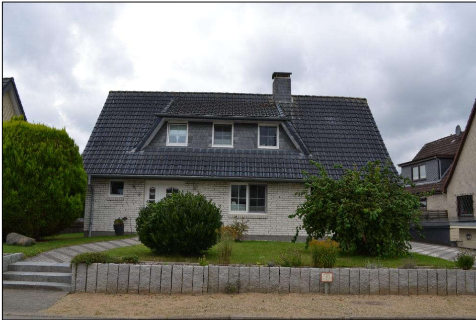
Bild 5: Straßen-/Ostansicht des Grundstücks/des Gebäudes
