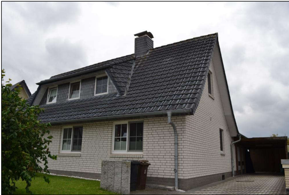
Bild 9: Nordostansicht des Gebäudes
