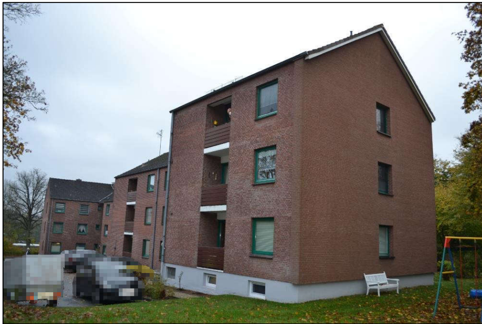
Bild 9: Südostansicht des Gebäudes als Gesamtansicht
