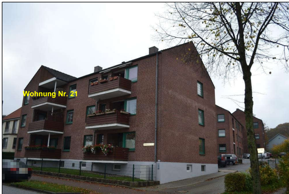
Bild 5: Straßen-/Ostnordansicht des Grundstücks/des Gebäudes
