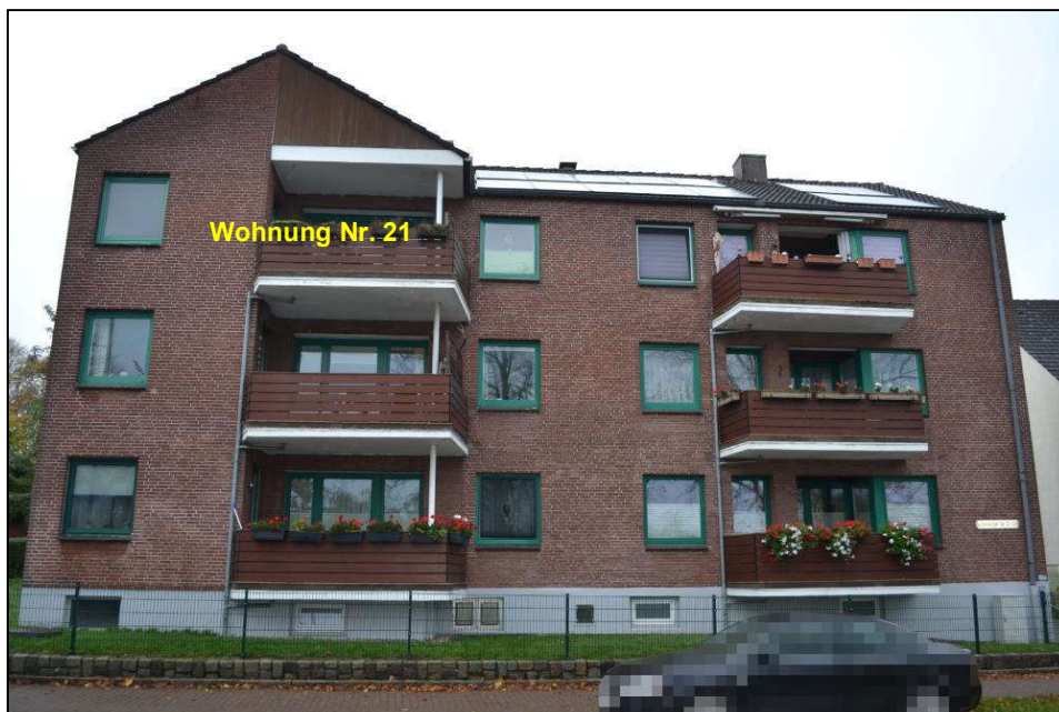
Bild 4: Straßen-/Südostansicht des Grundstücks/des Gebäudes
