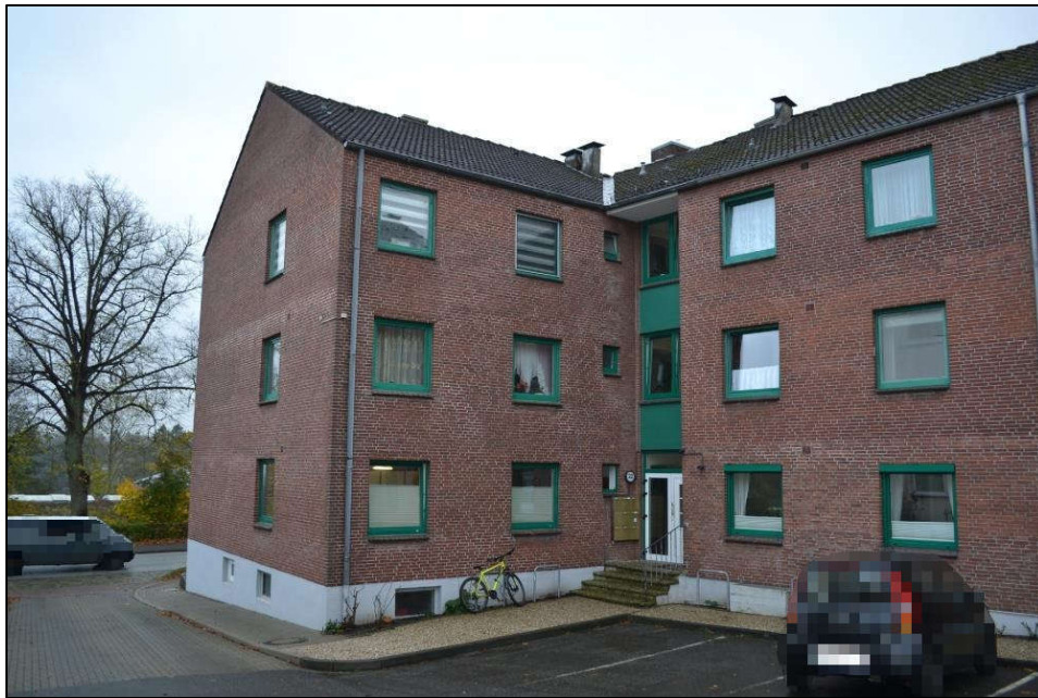
Bild 7: Südsüdostansicht des Gebäudes
