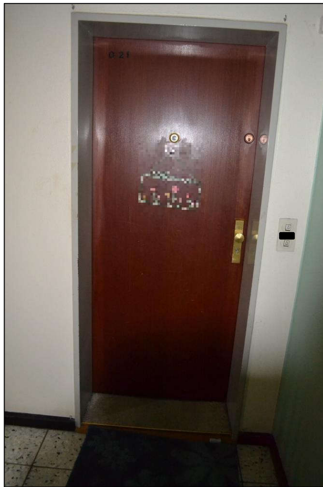
Bild 13: Eingangstür der Wohnung Nr. 21 im 2. OG
