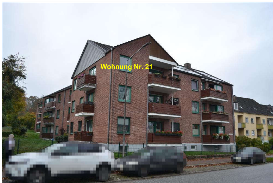
Bild 3: Straßen-/Südsüdostansicht des Grundstücks/des Gebäudes
