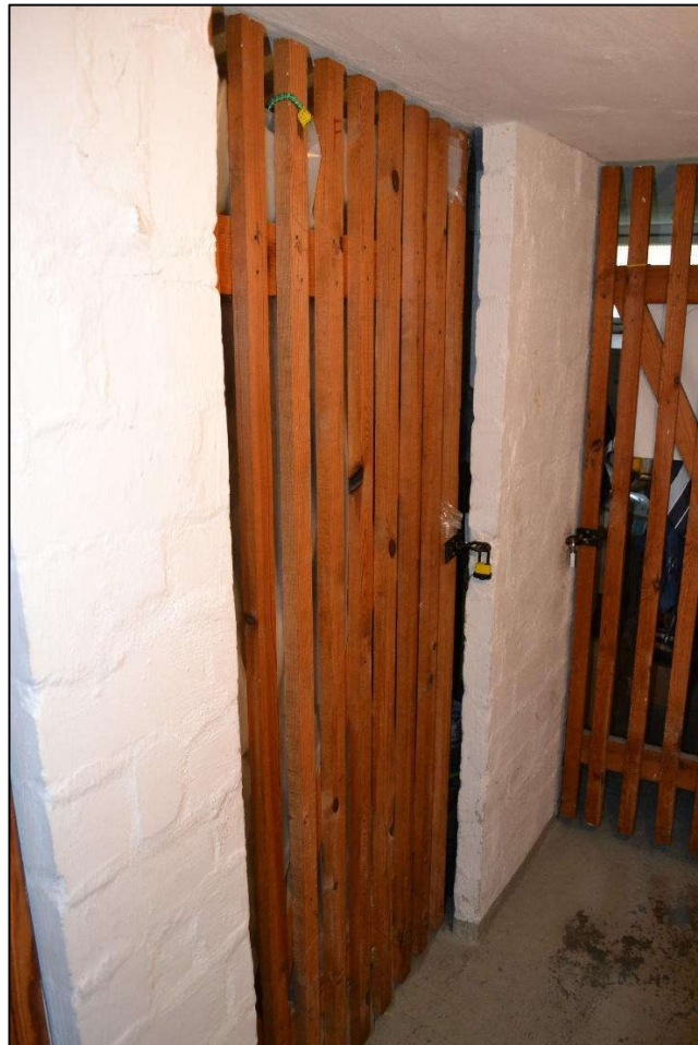
Bild 12: Kellerabstellraum (von der Mieterin genutzt)
