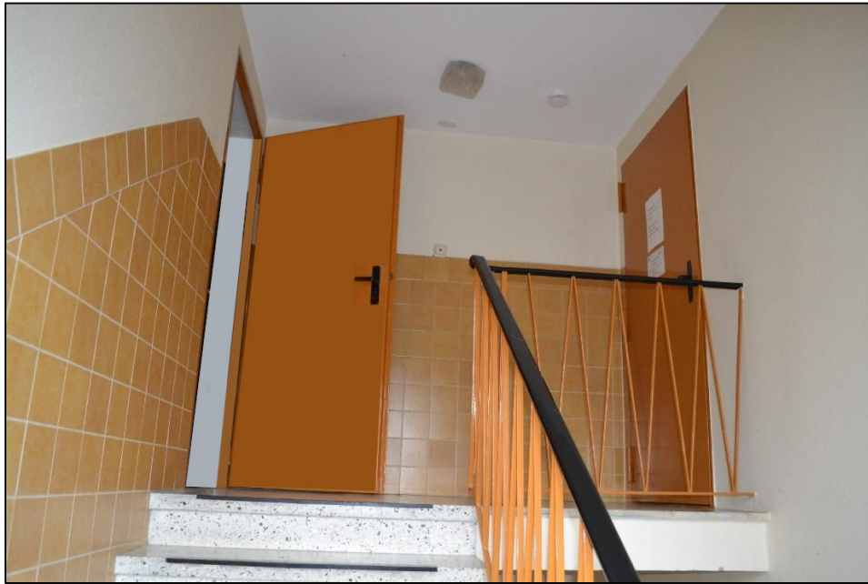
Bild 15: Treppenhaus auf DG-Niveau
