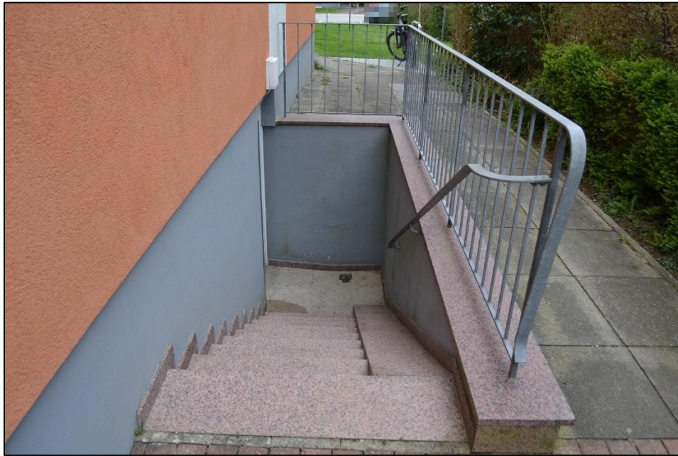
Bild 5: Außentreppe zum Keller
