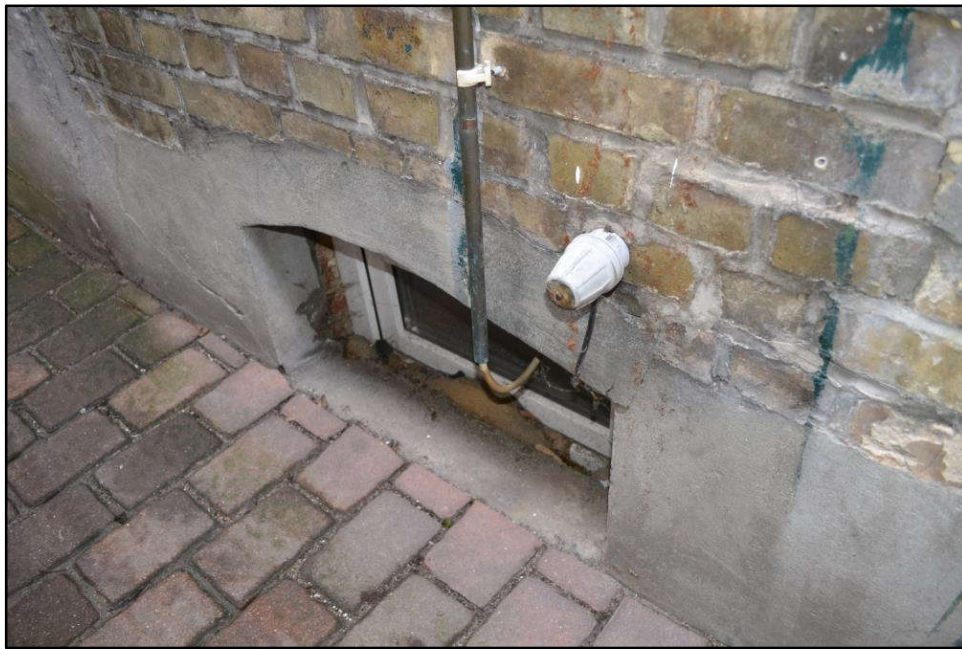
Bild 11: Kellerraumfenster als Detailaufnahme
