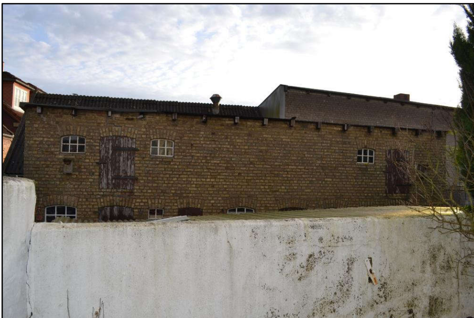
Bild 22: Westansicht des die südliche Grenze überschreitenden Hofgebäudes
