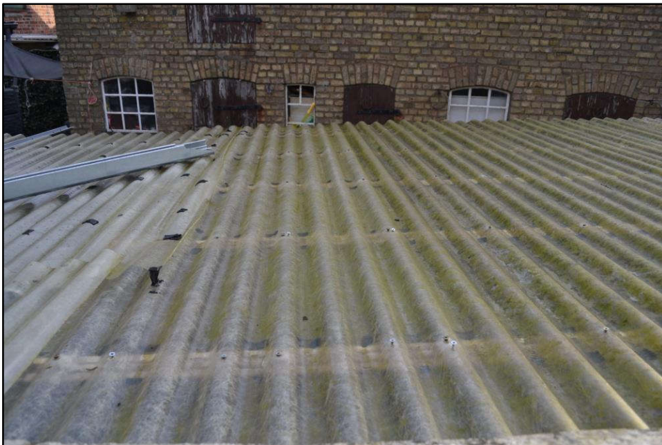
Bild 23: Draufsicht der Überdachung an der Westgrenze
