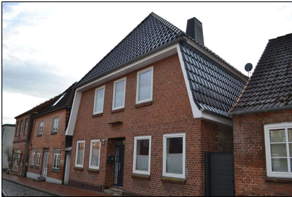
Bild 5: Schrägansicht des Wohnhauses als Westseite
