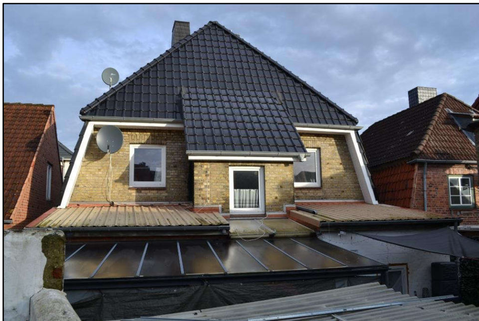
Bild 18: Rück/-Südansicht des Wohnhauses von einem höher liegenden Nachbargrundstück
