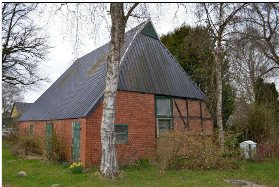
Bild 12: Südostansicht des Stallgebäudes 1 an der Straßenecke Am Höben / Am Pool 2
