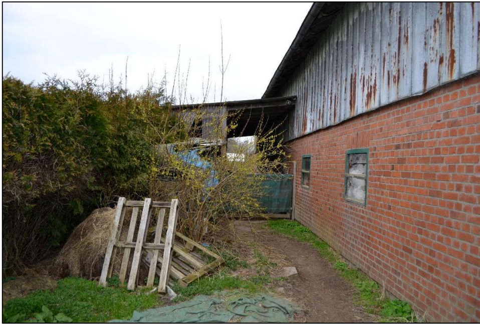
Bild 23: Blick entlang der Westseite des Stallgebäudes 2 in Nordrichtung
