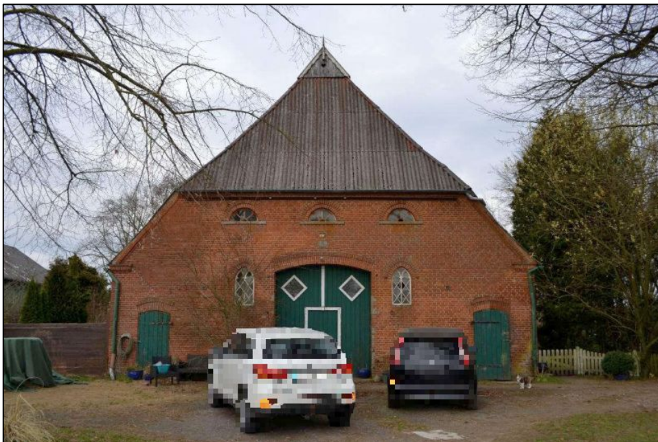
Bild 16: Südansicht des Wohn- und Wirtschaftsgebäudes
