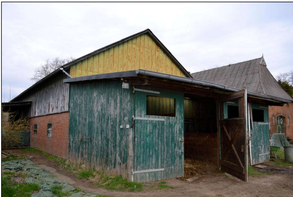
Bild 22: Südwestansicht des Stallgebäudes 2
