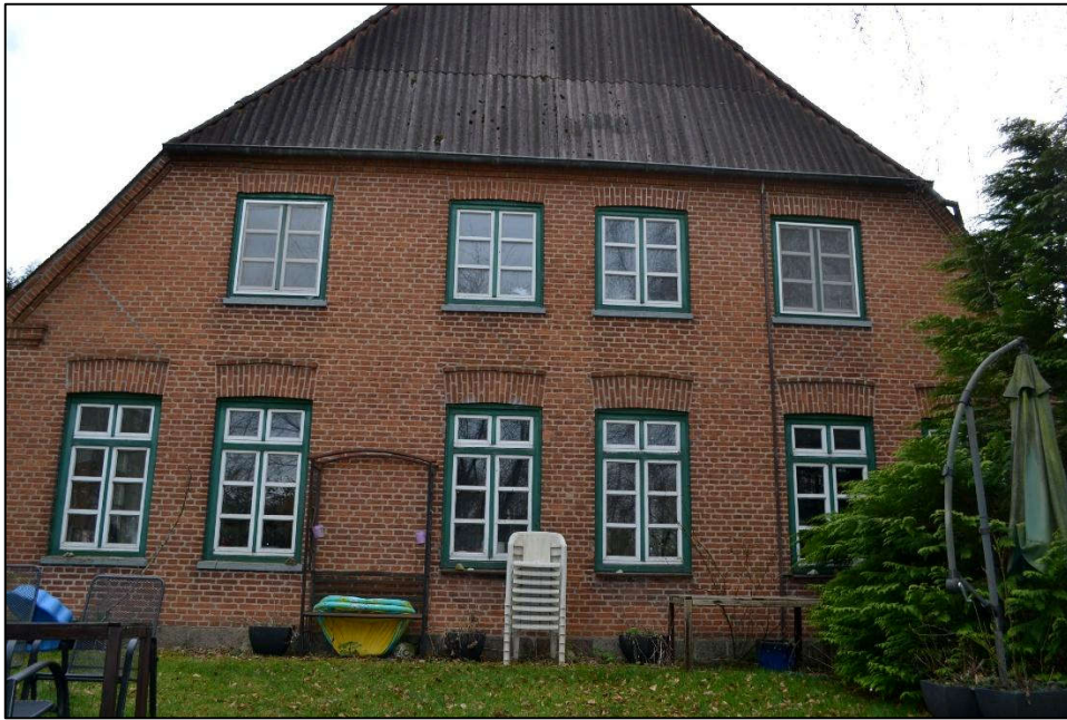
Bild 7: Nordansicht des Wohn- und Wirtschaftsgebäudes
