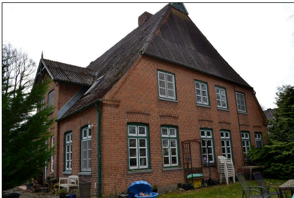
Bild 6: Nordostansicht des Wohn- und Wirtschaftsgebäudes
