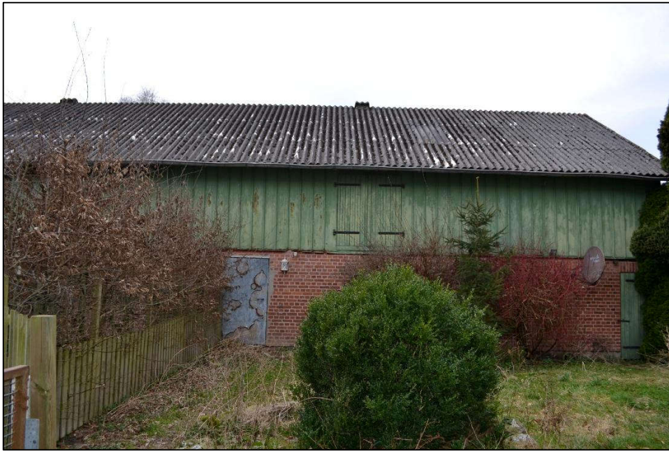
Bild 29: Ostansicht des Stallgebäudes 2
