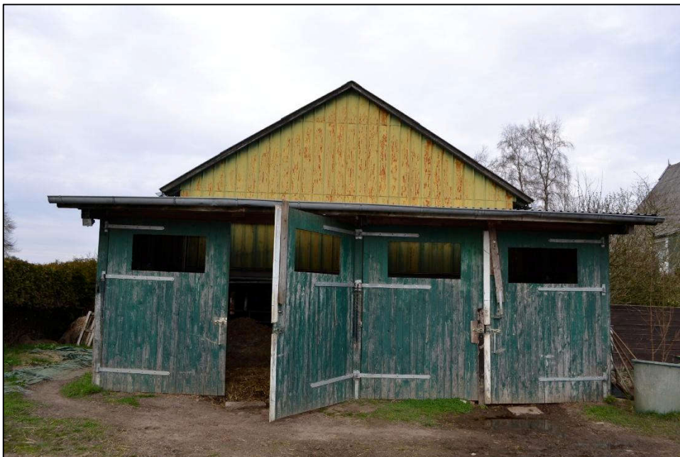
Bild 20: Südansicht des Stallgebäudes 2
