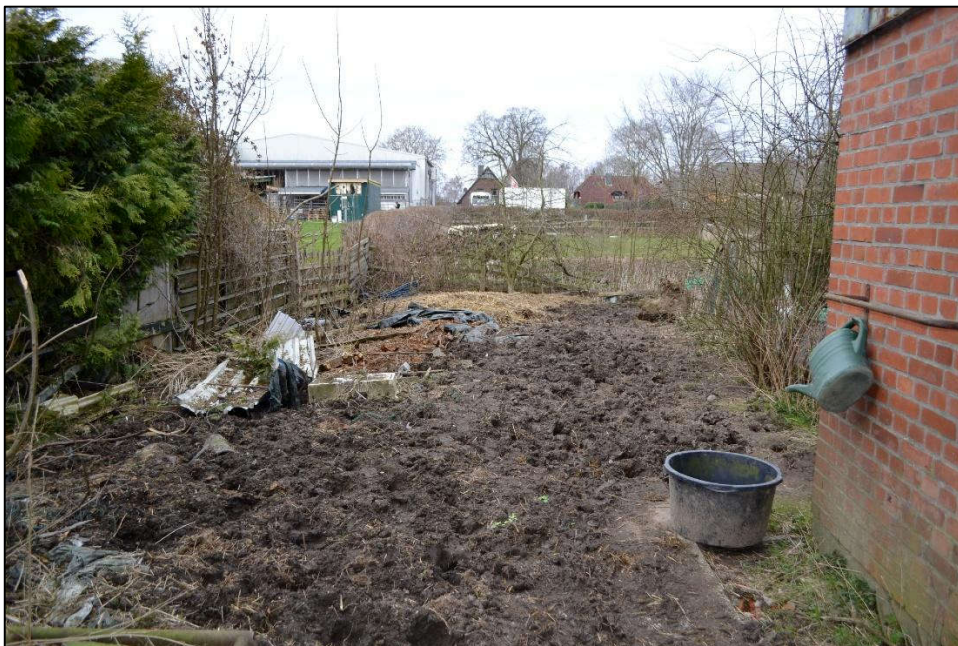
Bild 26: Blick hinter dem Pultdachanbau in Nordrichtung
