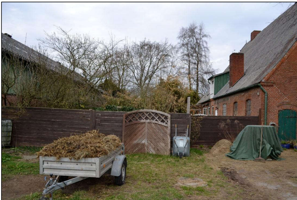
Bild 18: Blick zwischen Stallgebäude 2 und Wohn- und Wirtschaftsgebäude in Nordrichtung
