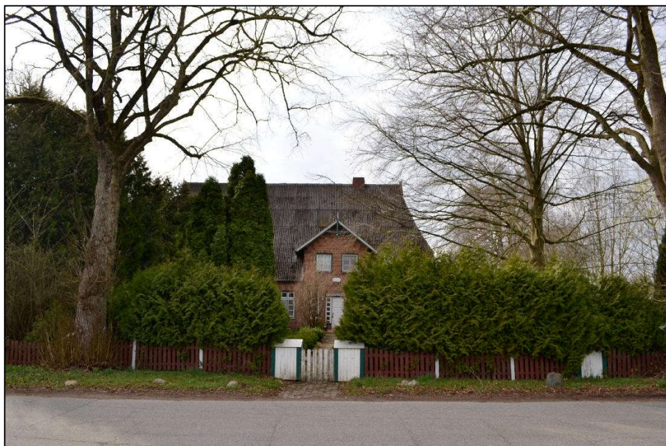
Bild 2: Straßen- bzw. Ostansicht des Grundstücks
