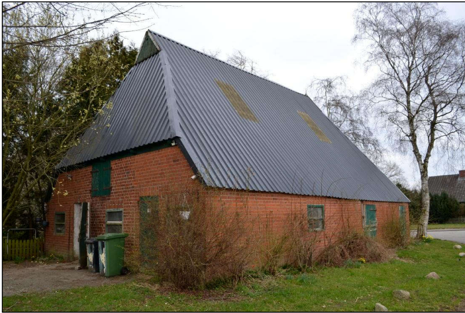
Bild 13: Südwestansicht des Stallgebäudes 1
