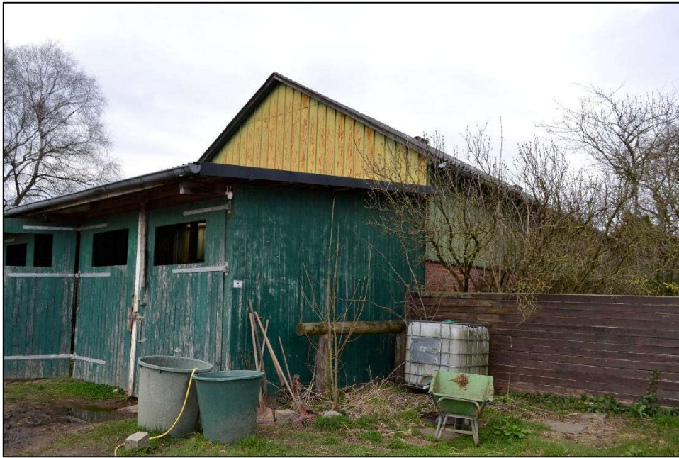
Bild 19: Südostansicht des Stallgebäudes 2
