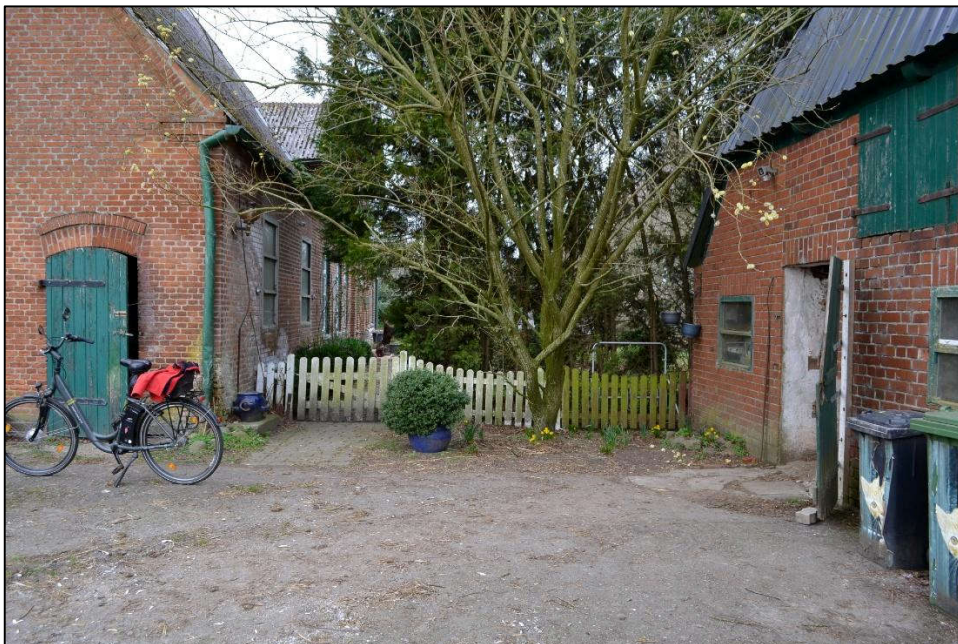
Bild 14: Blick zwischen Wohn- und Wirtschaftsgebäude und Stallgebäude 1 in Nordrichtung
