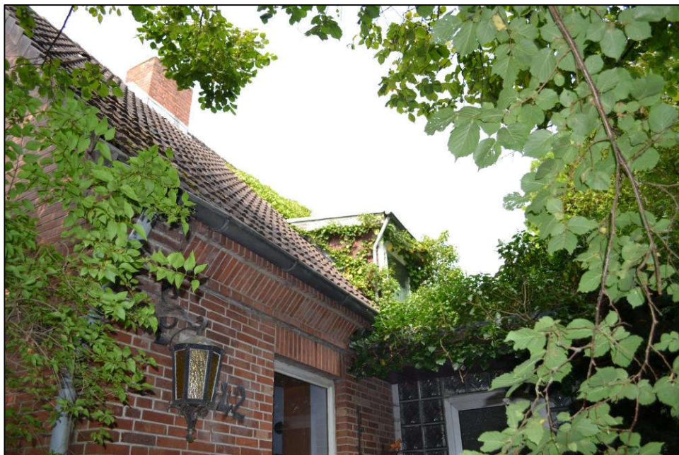
Bild 14: Blick zur Dachfläche mit Gaube
