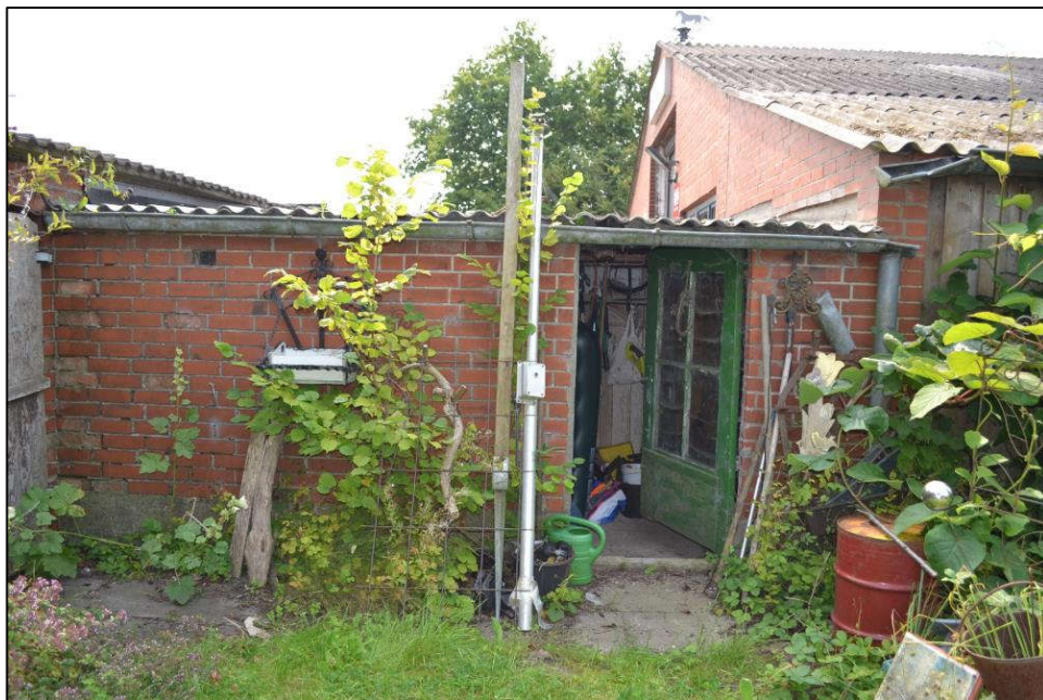
Bild 18: Schuppen an der südlichen Grenze
