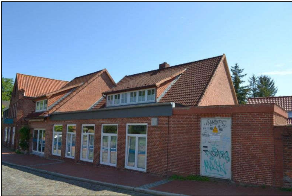
Bild 3: Südwestansicht des Gebäudes
