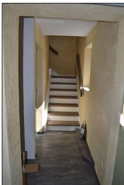
Bild 25: Flur vor der DG-Treppe
