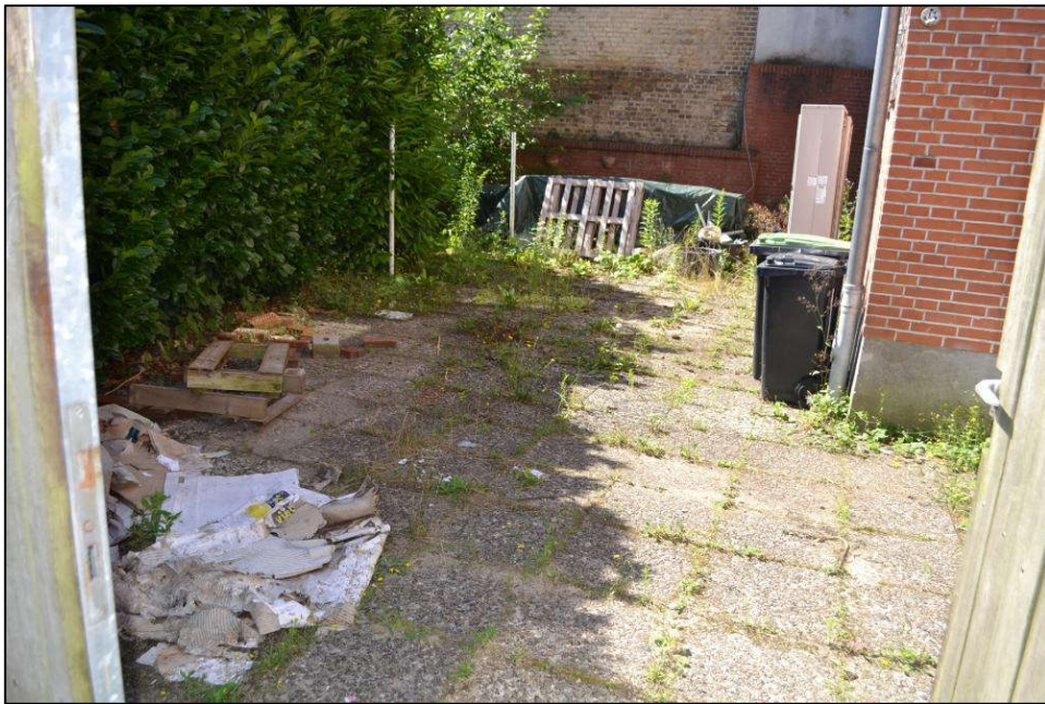
Bild 11: Blick in den Hofplatz
