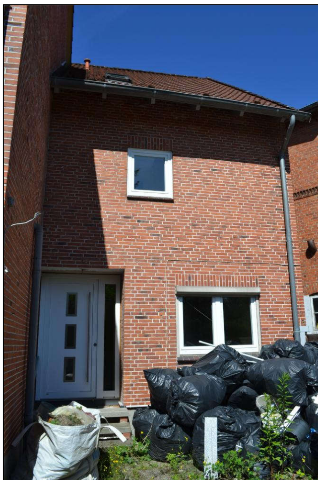
Bild 13: Ostansicht des Anbaus
