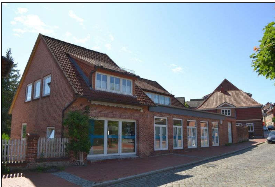
Bild 5: Nordwestansicht des Gebäudes
