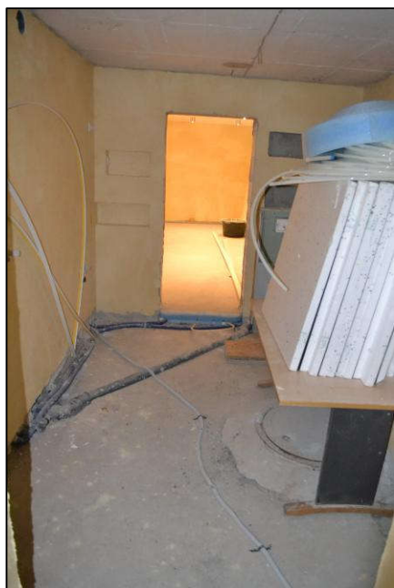
Bild 39: Kellerraum (geplant Bad)
