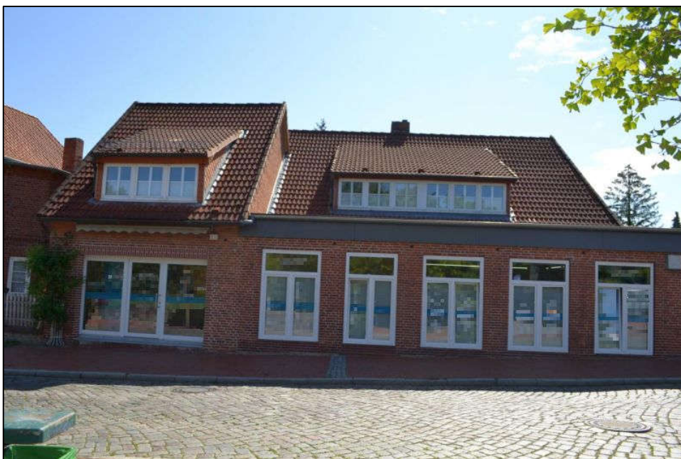
Bild 4: Westansicht des Gebäudes
