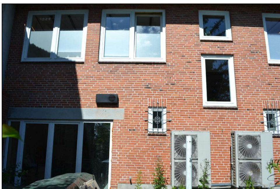
Bild 14: Ostansicht des Hauptgebäudes
