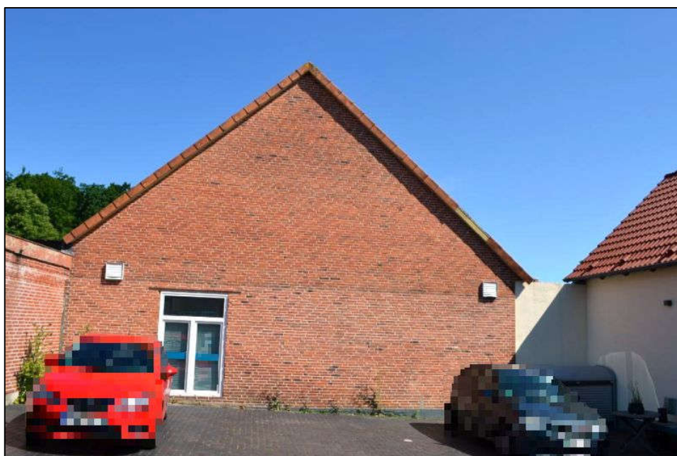
Bild 2: Südansicht des Gebäudes
