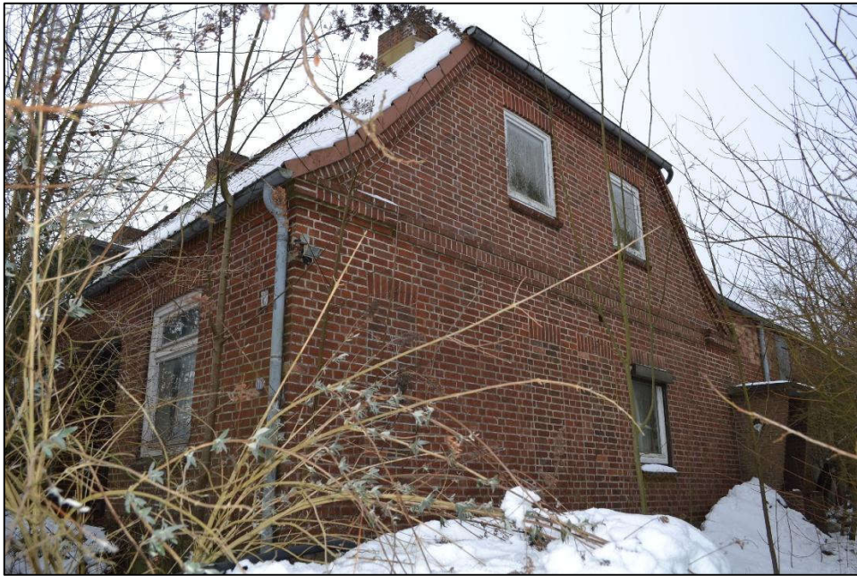
Bild 5: Nordostansicht des Gebäudes
