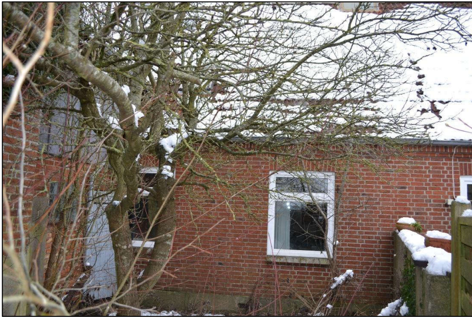
Bild 13: Westansicht des Gebäudes
