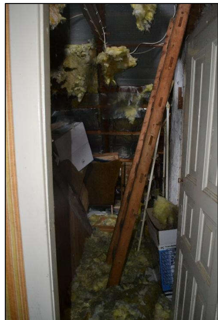
Bild 46: Tür zum östlichen Bodenraum
