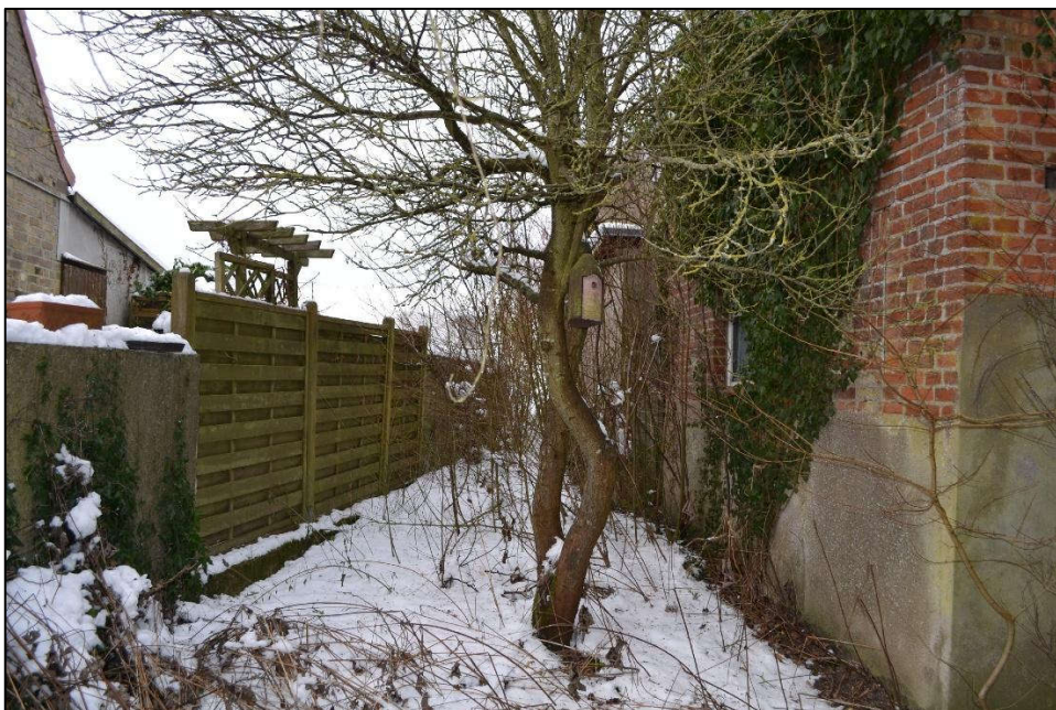
Bild 14: Blick entlang der Südseite des Stallteils nach Westen
