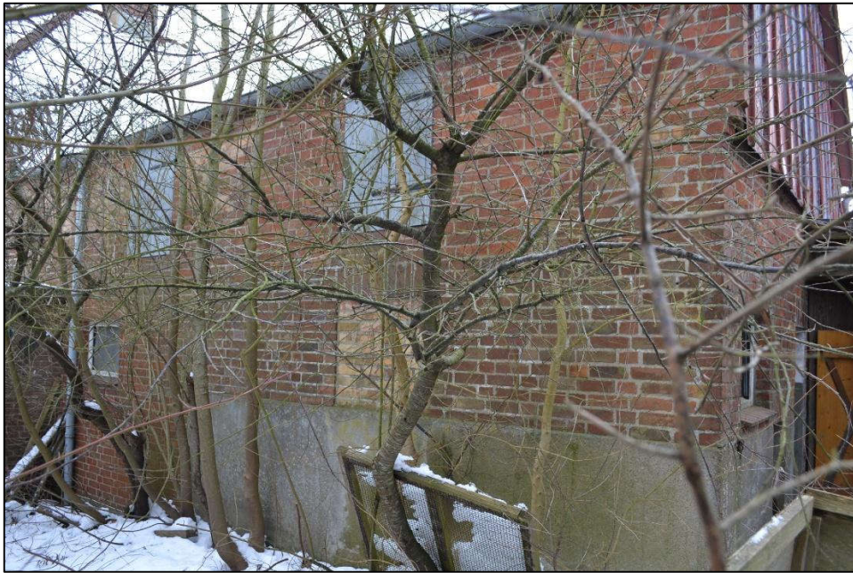
Bild 11: Nordwestansicht des Stallteils
