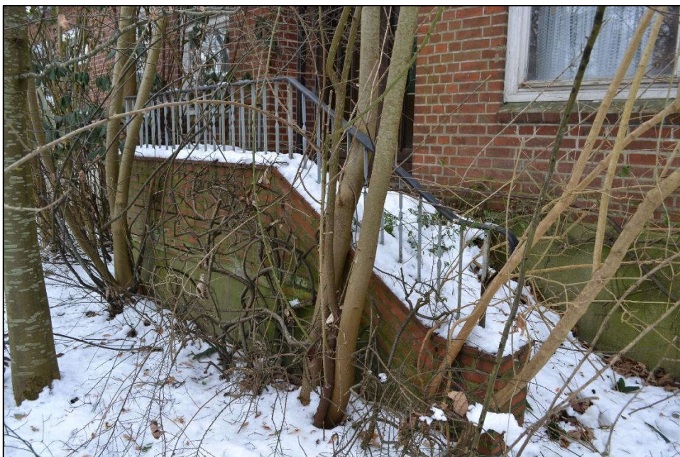
Bild 6: Treppenaufgang vor der Hauseingangstür
