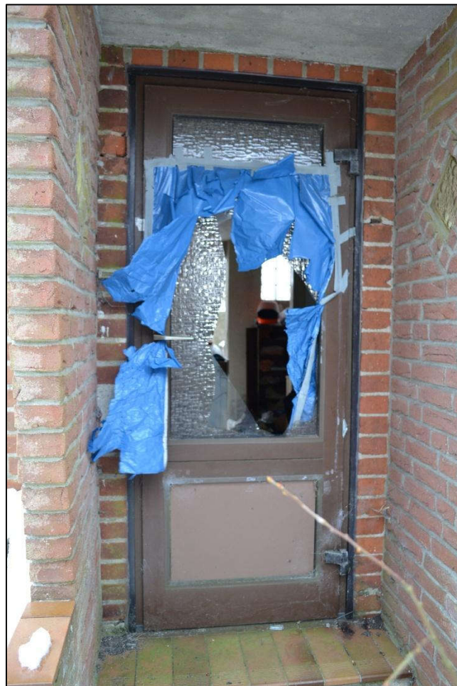
Bild 10: Nebeneingang auf der Nordseite
