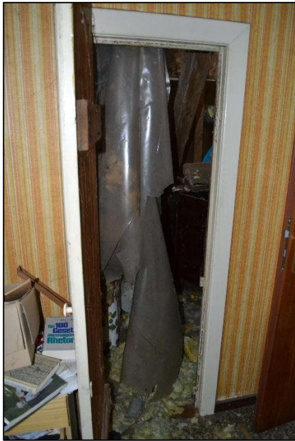
Bild 43: Tür zum westlichen Bodenraum
