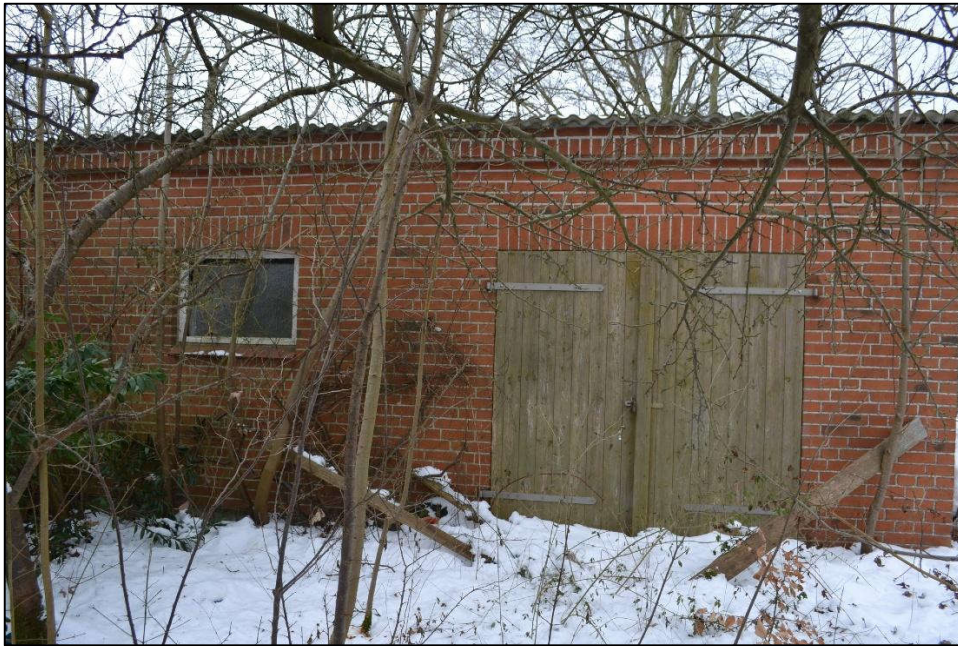
Bild 15: Vorder-/Ostansicht des Nebengebäudes mit Garage
