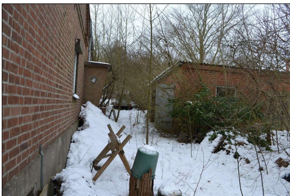
Bild 8: Blick entlang der Gebäudenordseite nach Westen
