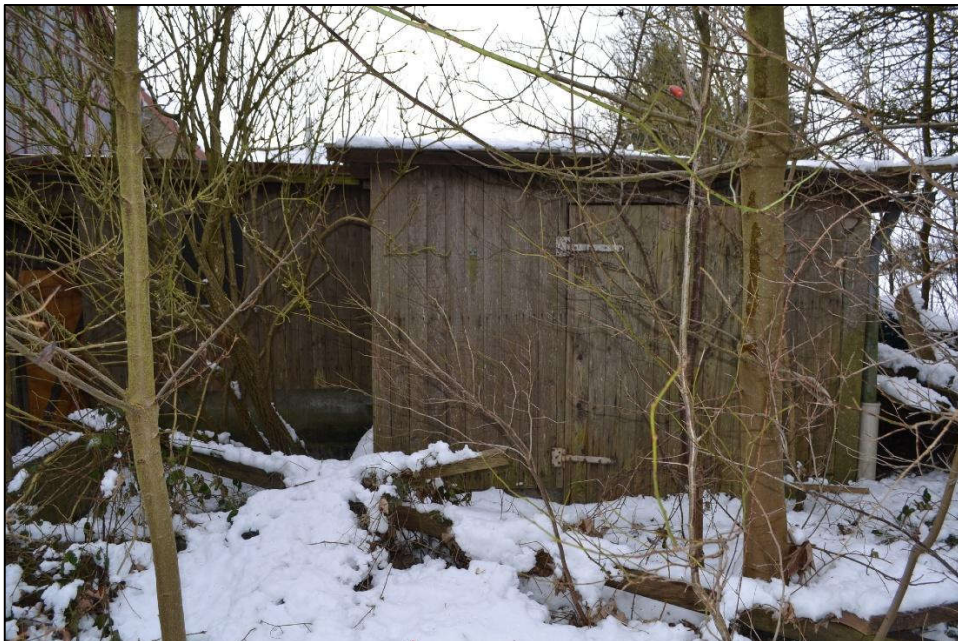
Bild 12: Nordansicht der Schuppenanbauten
