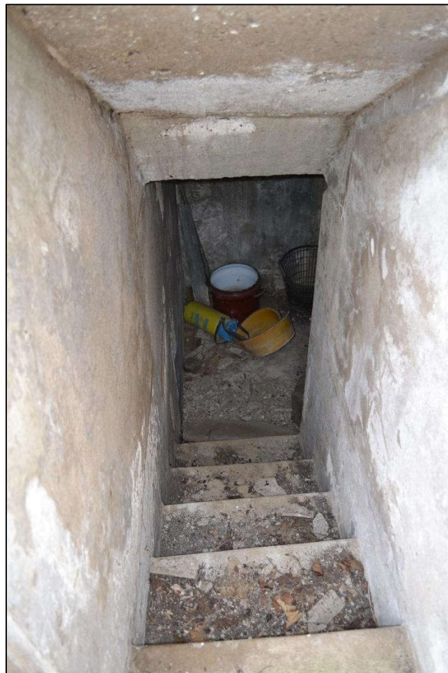
Bild 20: Blick in den Luftschutzraum
