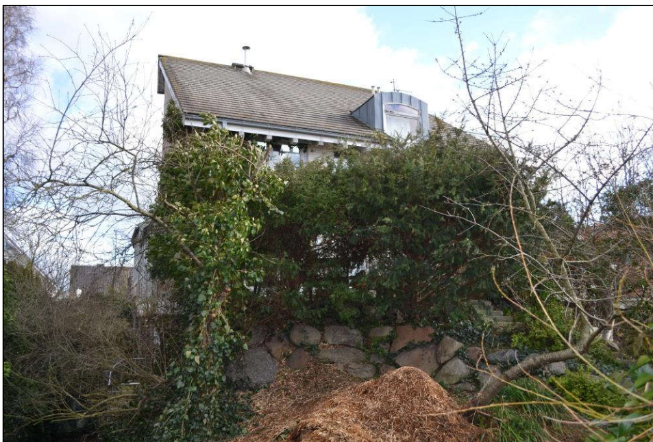
Bild 8: Blick über das Tor zum Gebäude (Südwestseite)
