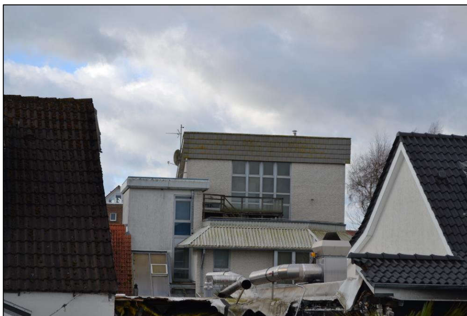
Bild 20: Nordostansicht des Gebäudes mit Zoomfunktion
