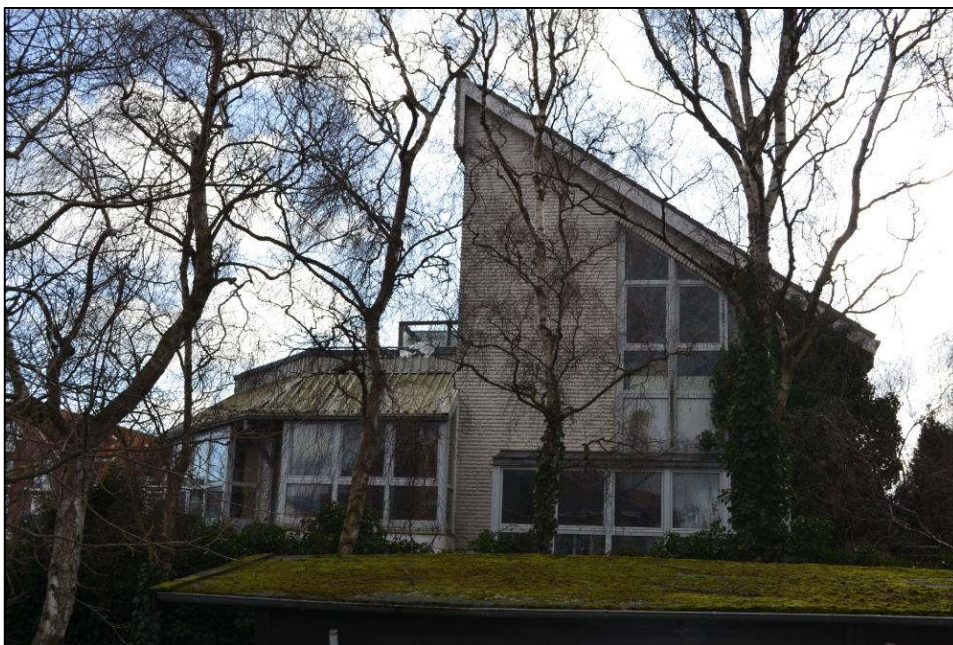
Bild 4: Nordwestansicht des Grundstücks/des Gebäudes (vom Nachbargrundstück aus)
