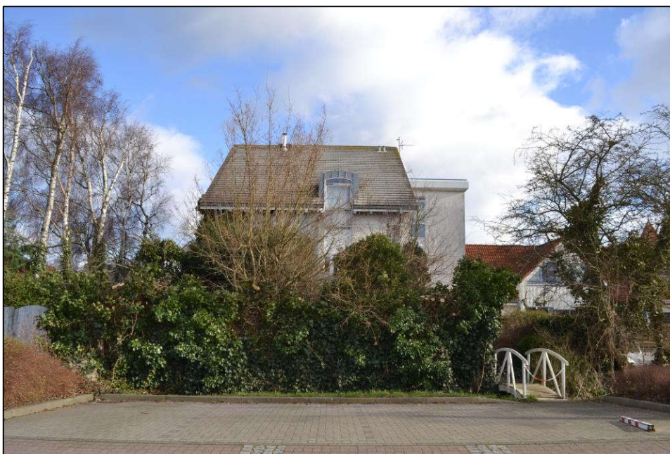
Bild 3: Straßen-/Südwestansicht des Grundstücks/des Gebäudes
