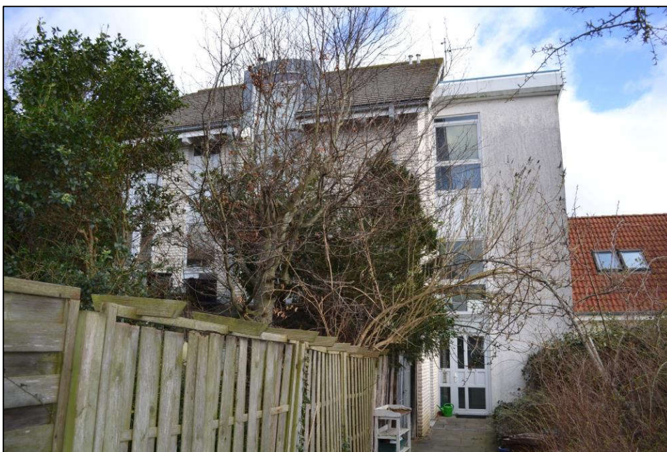
Bild 13: Vorderansicht des Gebäudes mit Treppenhaus
