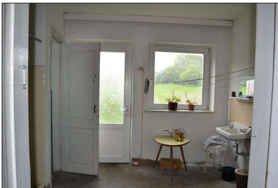
Bild 26: Hauswirtschafts- bzw. Sanitär- und Heizungsraum
