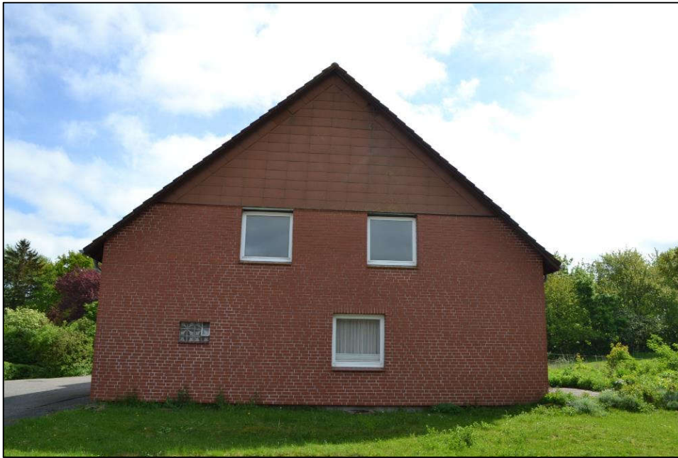
Bild 7: Westansicht des Gebäudes
