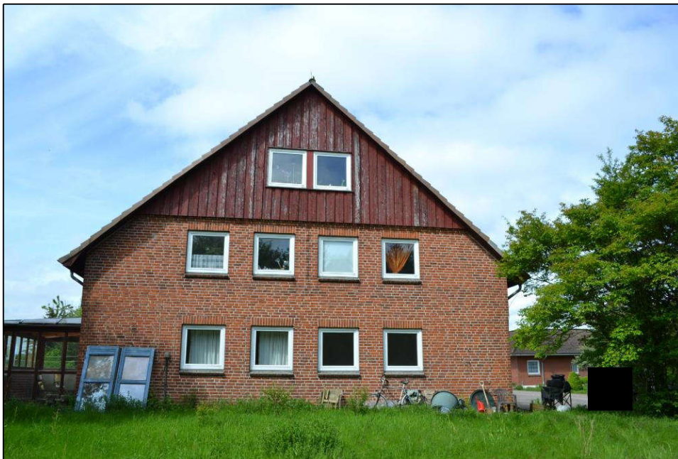
Bild 11: Ostansicht des Gebäudes
