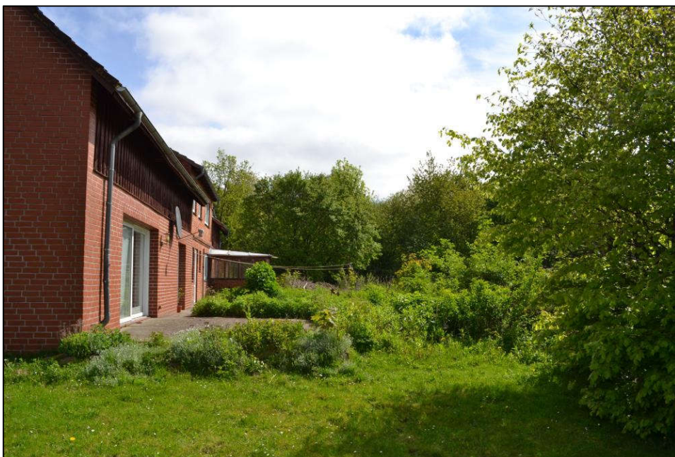
Bild 14: Blick über die Grundstücksfreifläche im Süden
