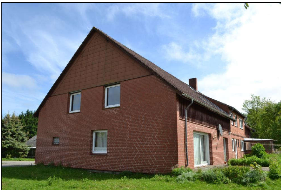
Bild 8: Südwestansicht des Gebäudes
