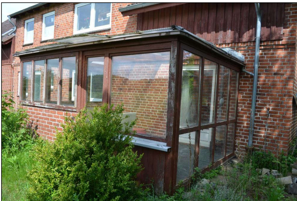
Bild 10: Wintergartenanbau auf der Gebäudesüdseite
