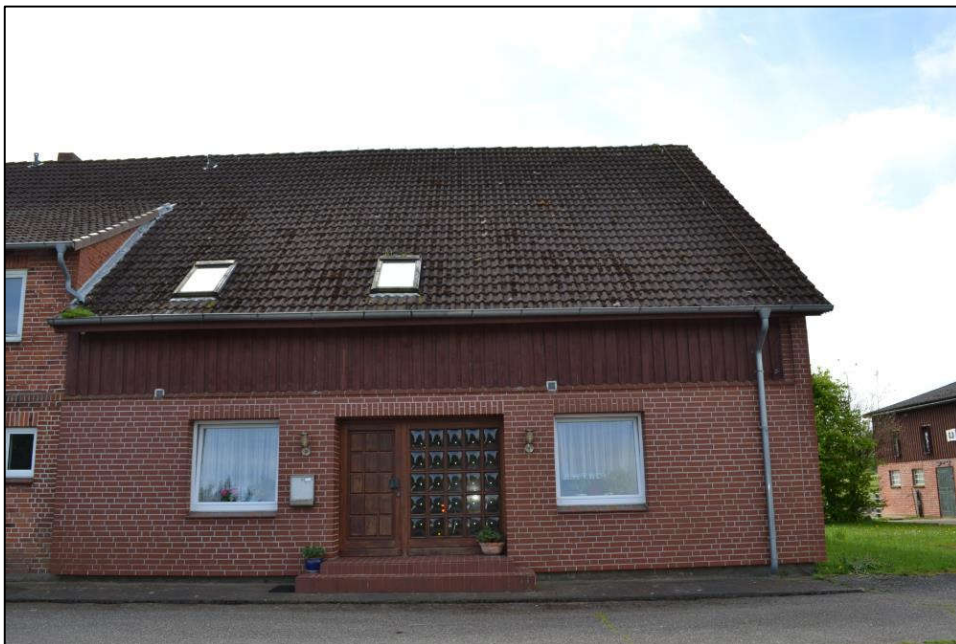
Bild 40: Nordansicht des westlichen Gebäudeteils (WE 3)
