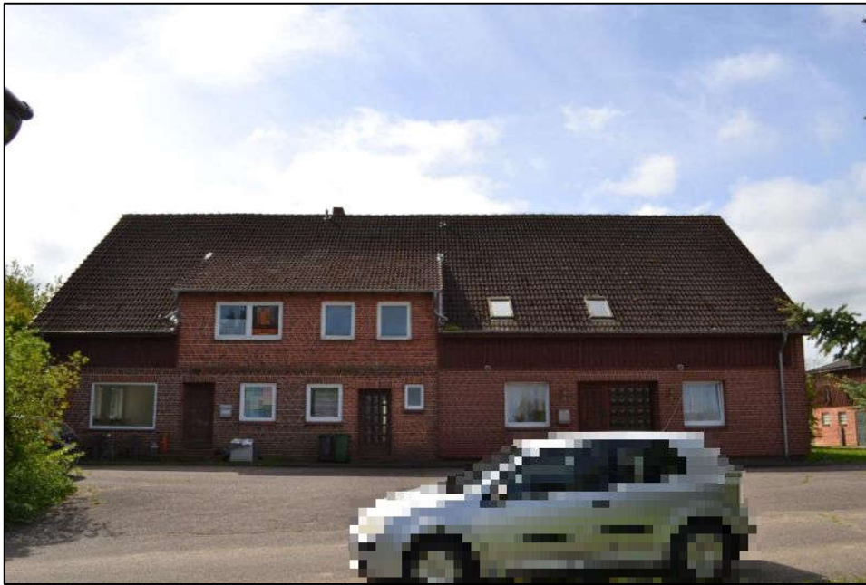
Bild 5: Nordansicht des Gebäudes
