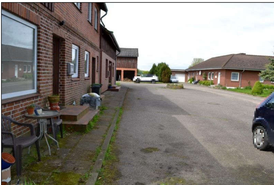
Bild 12: Blick über den Gebäudevorplatz im Norden
