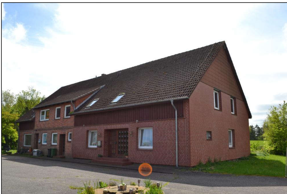
Bild 6: Nordwestansicht des Gebäudes
