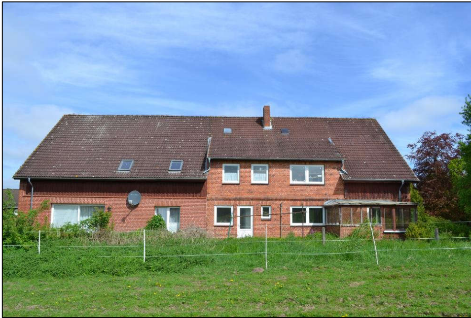
Bild 9: Südansicht des Gebäudes
