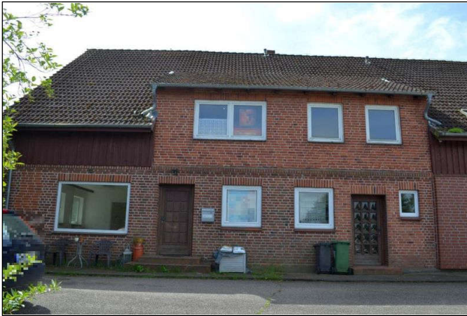
Bild 19: Nordansicht des östlichen Gebäudeteils
