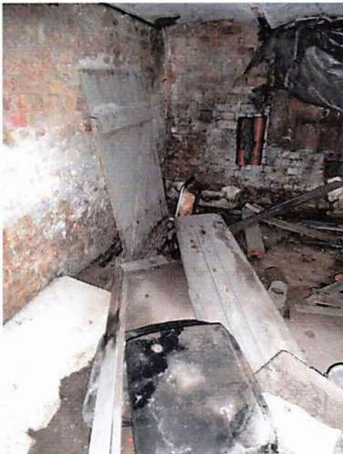
Bild 95: Situation Teilkeller / Feuchtigkeitsschäden
