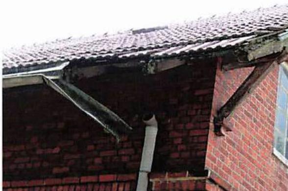
Bild 99: Schaden Hauptdach
