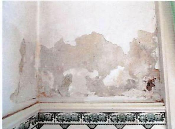
Bild 42: EG Küche Feuchtigkeitsschäden Außenwand
