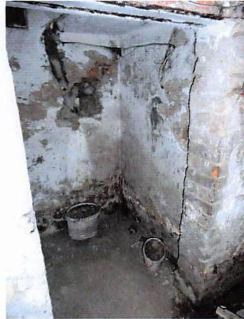
Bild 98: Situation Teilkeller / Feuchtigkeitsschäden
