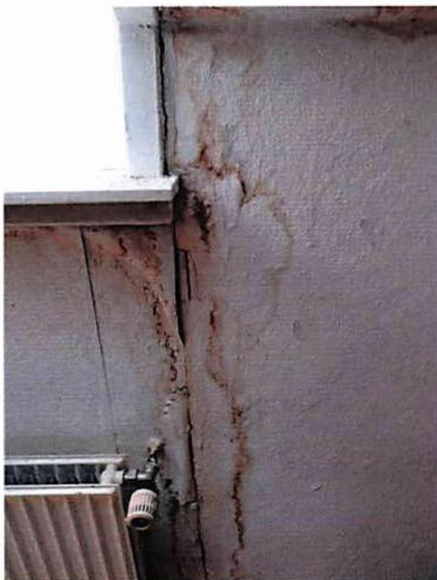
Bild 63: DG leere Whg. Zimmer / Feuchtigkeitsschaden
