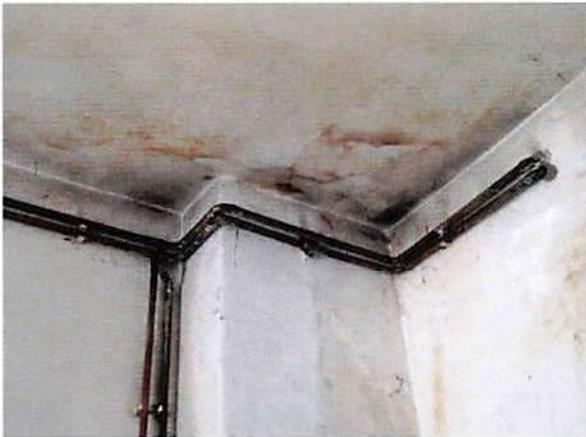
Bild 51: EG Raum Feuchtigkeitsschaden Decke
