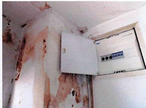
Bild 68: DG leere Whg. Küche / Elektrik / Feuchtigkeitsschaden
