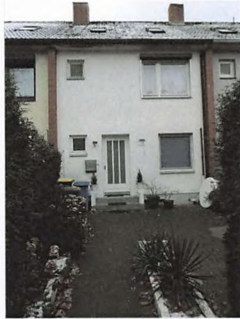
Bild 10: Ansicht Bewertungsobjekt / Eingangsseite
