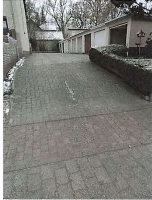
Bild 18: Bereich Nedderstraße Auffahrt Garagengebäude
