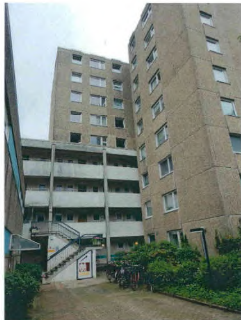
Bild 10: Ansicht Wohnanlage, rückseitig
