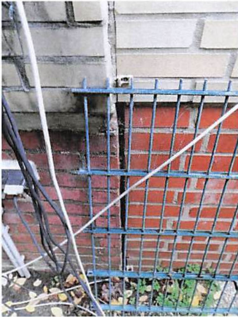
Bild 21: Situation Fassade, Übergang Altbau / Anbau, Rissbildungen
