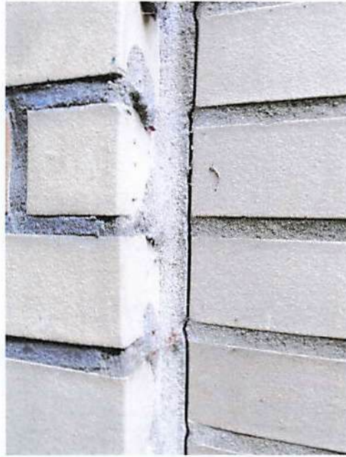
Bild 22: Situation Fassade, Rissbildungen, Übergang Altbau / Anbau
