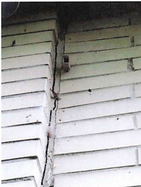
Bild 23: Situation Fassade, Rissbildungen, Übergang Altbau / Anbau
