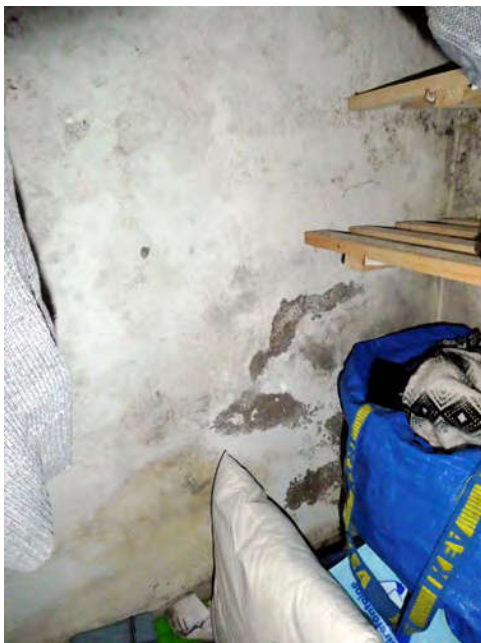
Bild 51: KG Feuchtigkeitsschäden
