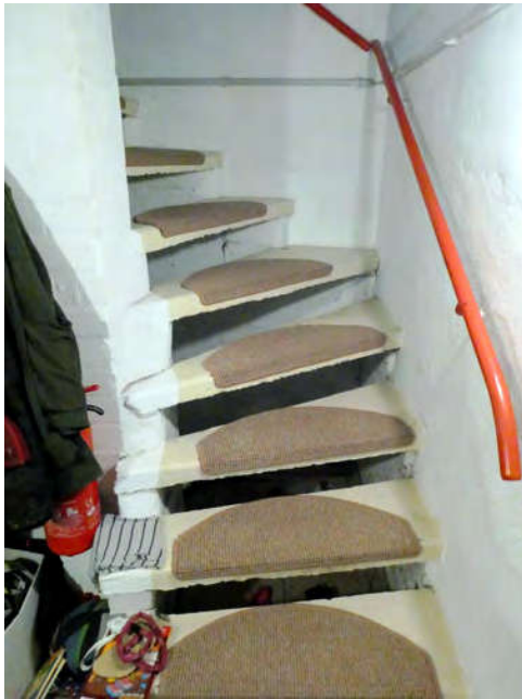
Bild 41: KG Treppe in das EG
