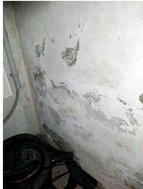
Bild 50: KG Feuchtigkeitsschäden
