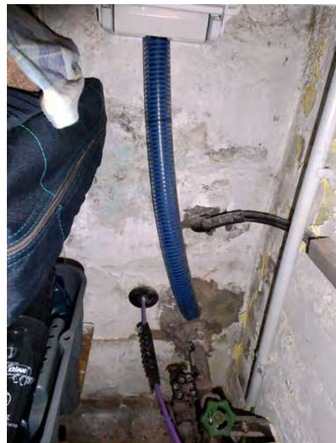
Bild 52: KG Feuchtigkeitsschäden
