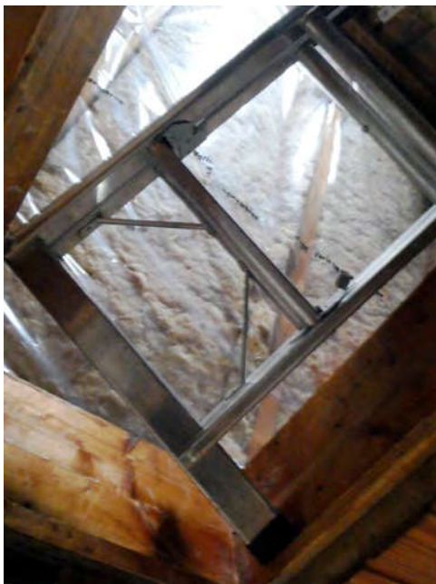
Bild 39: DG Blick in den Spitzboden
