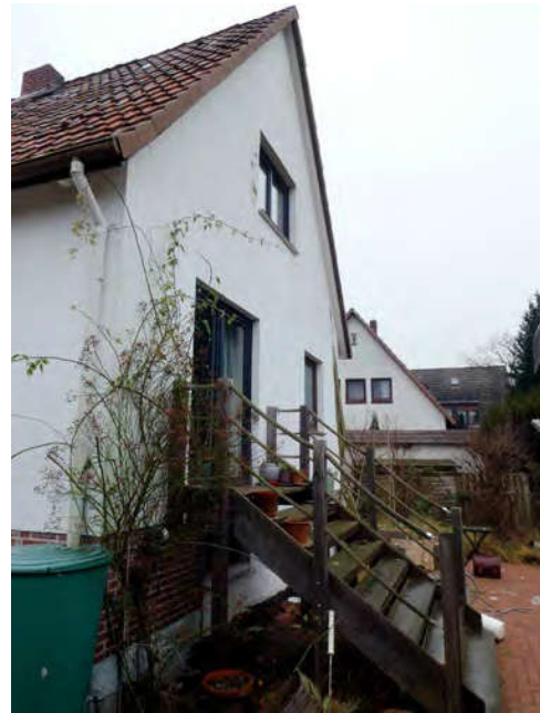
Bild 6: rückwärtige Teilansicht Giebel mit Treppe
