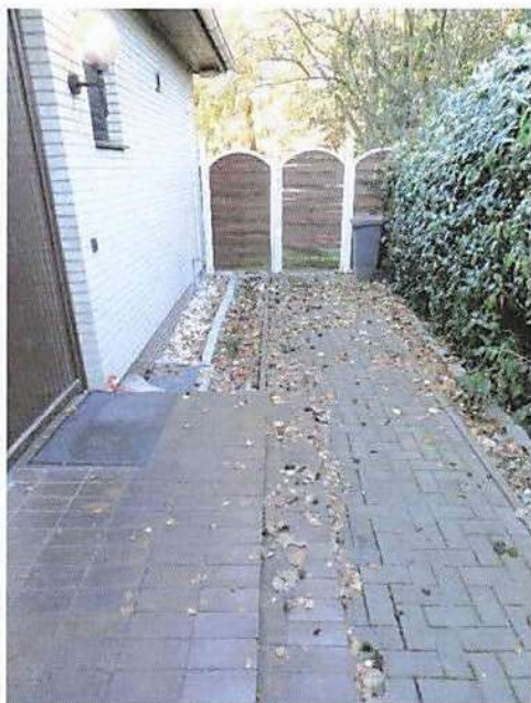
Bild 11: Teilansicht Wohnhaus Eingangsbereich
