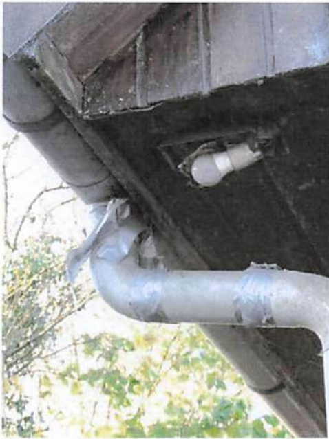
Bild 5: Garage / Situation Fallrohr
