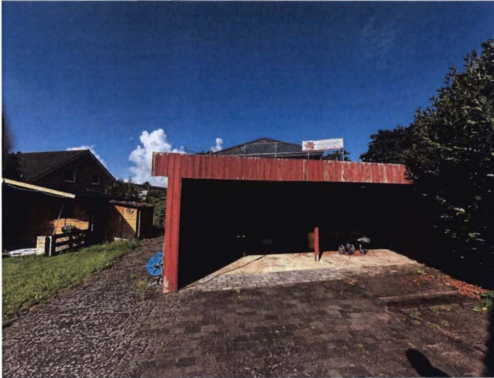
Ostansicht des Doppelcarports
