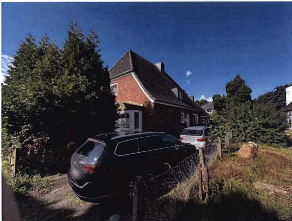
Nordostansicht des Wohnhauses
