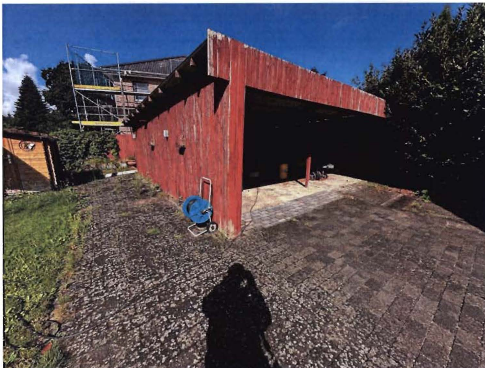
Südostansicht des Doppelcarports
