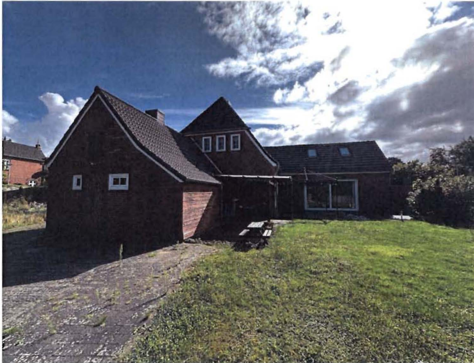
Westansicht des Wohnhauses mit Anbauten
