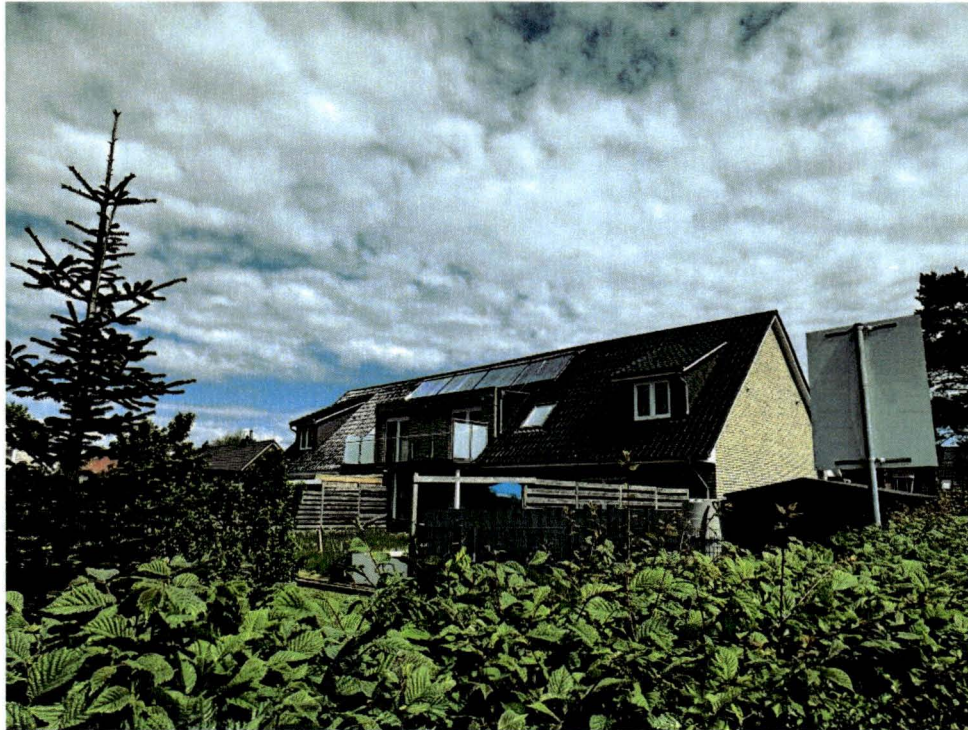
Südwestansicht des Reihenhauses
