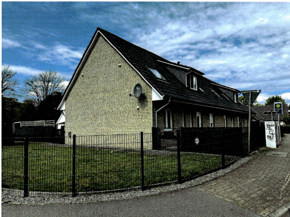
Südansicht des Reihenhauses
