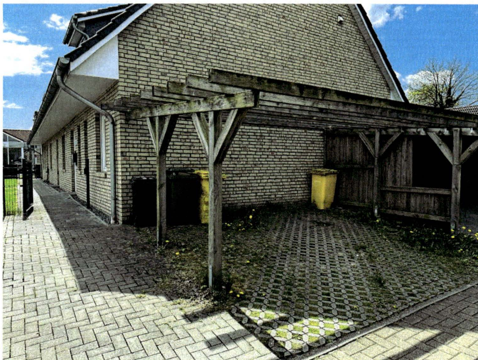
Nordansicht des Reihenhauses mit Pkw-Stellplatz Nr. 3
