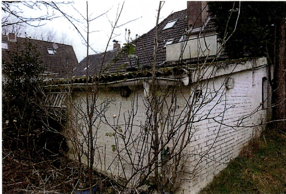
Bild 7: Ansicht aus südwestlicher Richtung
