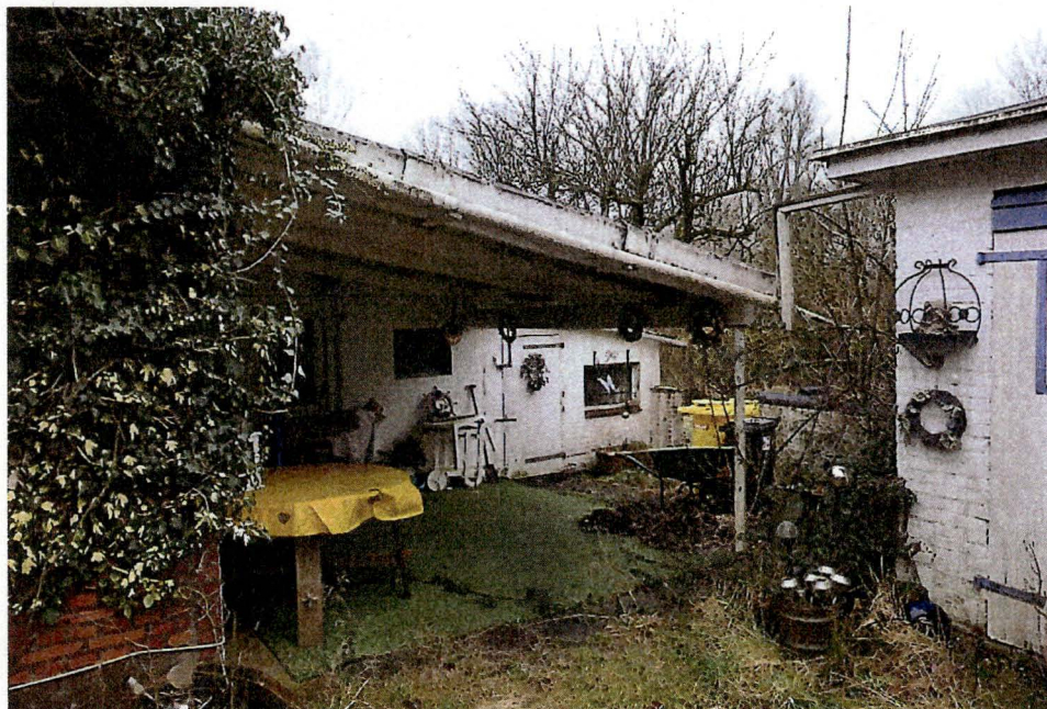
Bild 4: Ansicht Terrassenüberdachung und Anbau aus nordöstlicher Richtung
