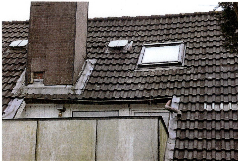
Bild 8: Ansicht aus westlicher Richtung
