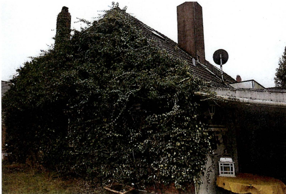
Bild 9: Ansicht aus nördlicher Richtung
