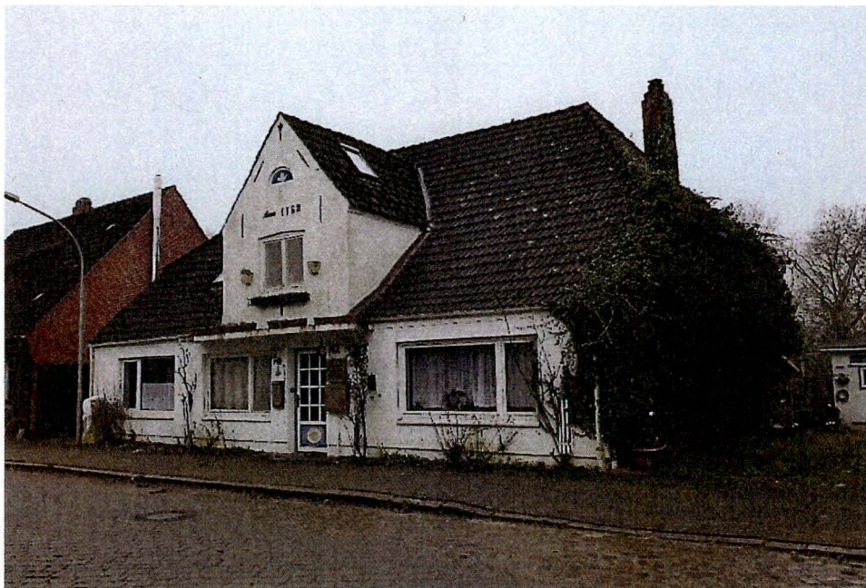
Bild 2: Ansicht aus nordöstlicher Richtung
