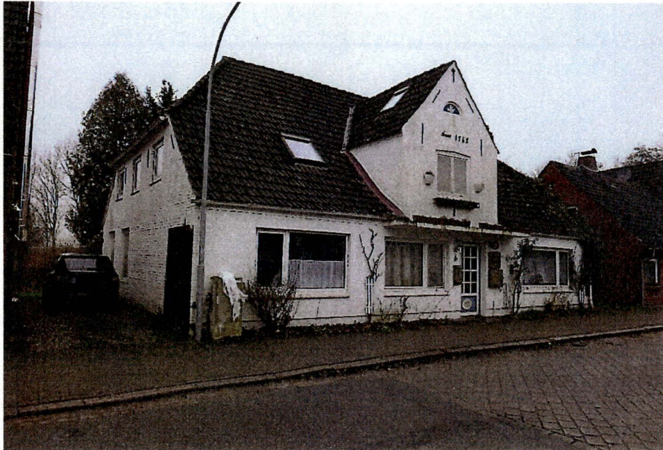
Bild 1: Ansicht aus südöstlicher Richtung
