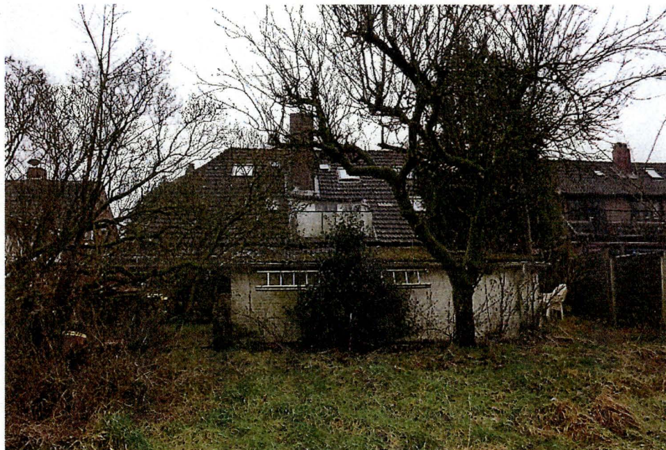
Bild 6: Ansicht aus westlicher Richtung
