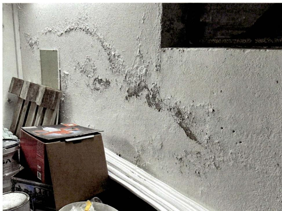
Beispiel für Feuchteschäden mit Putzabplatzungen im Keller
