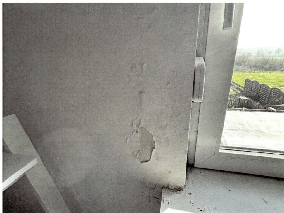
Beispiel für Feuchteschäden mit Putzabplatzungen im Dachgeschoss
