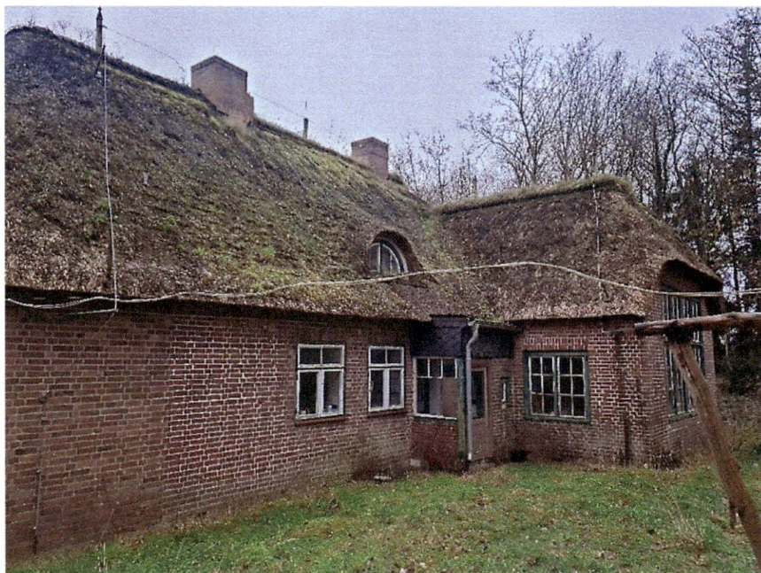
Bild 8: Ansicht aus nordöstlicher Richtung
