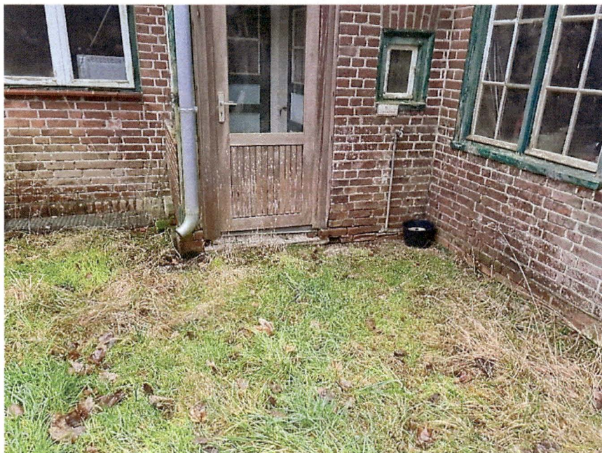
Bild 10: Ansicht aus nördlicher Richtung
