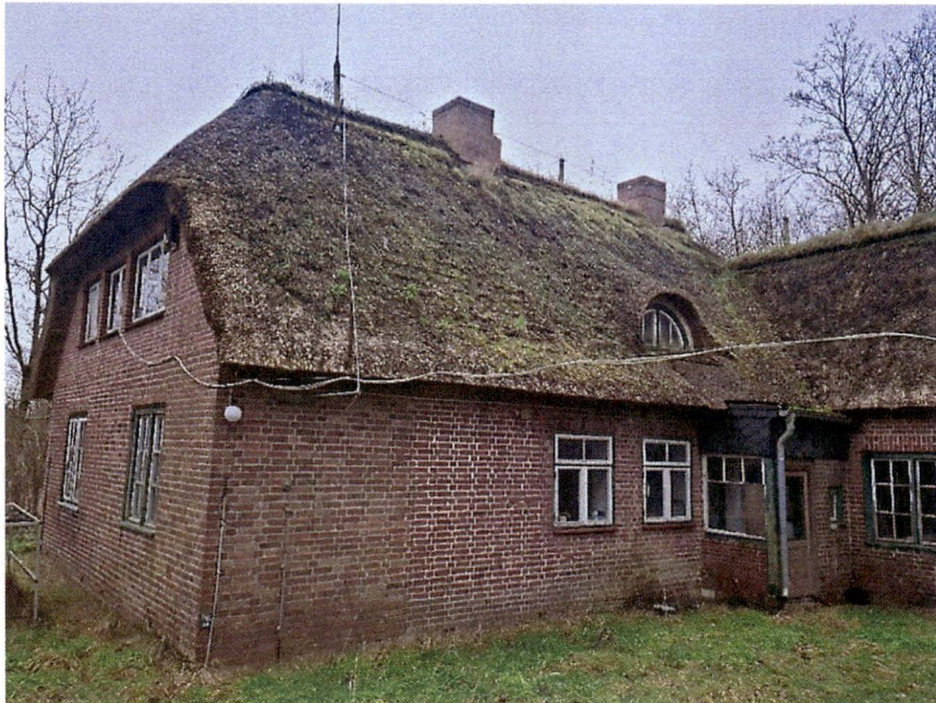
Bild 7: Ansicht aus nordöstlicher Richtung
