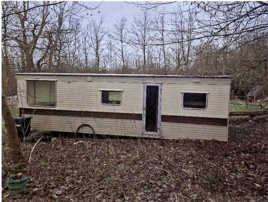
Bild 13: Ansicht aus nördlicher Richtung
