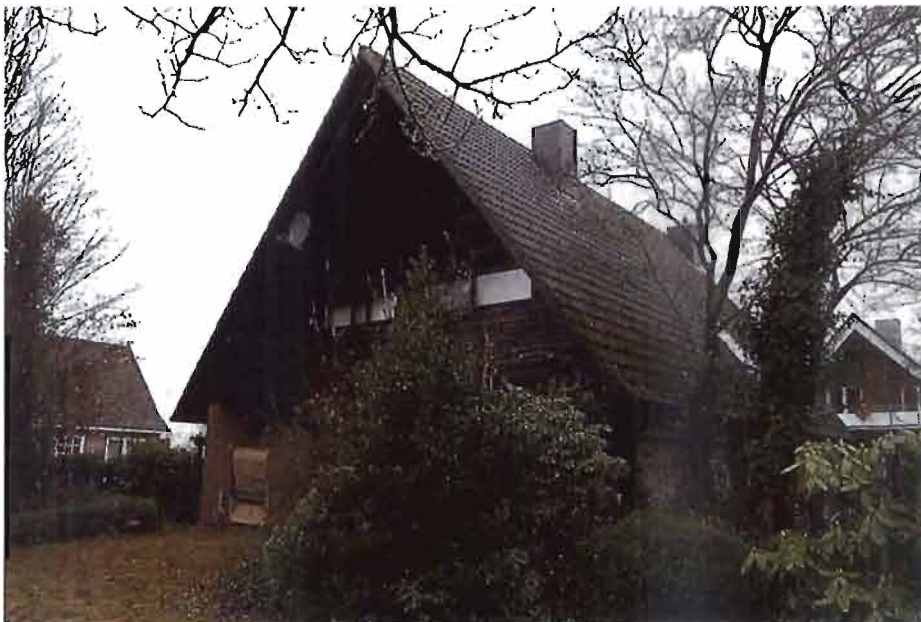
Foto 8: Ansicht aus südöstlicher Richtung
