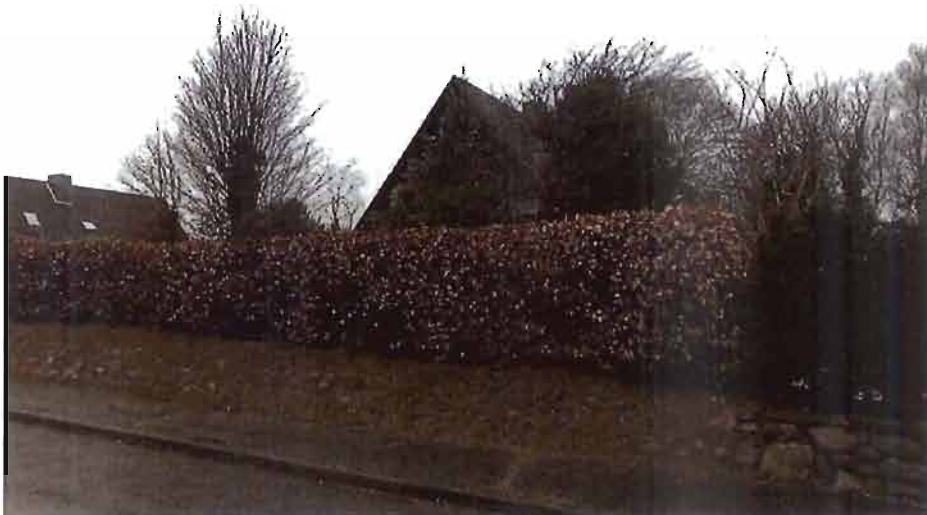
Foto 4: Ansicht aus südöstlicher Richtung
