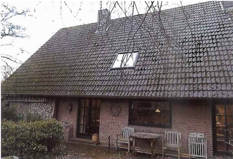
Foto 11: Ansicht aus östlicher Richtung
