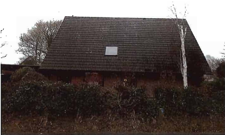
Foto 2: Ansicht aus westlicher Richtung
