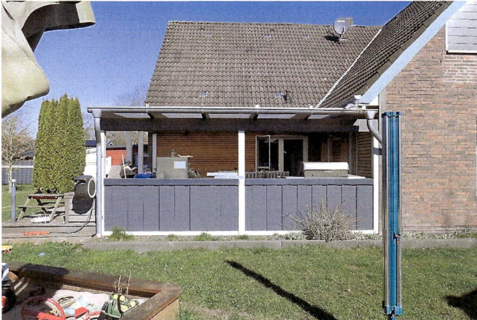
Bild 5: Ansicht aus südöstlicher Richtung
