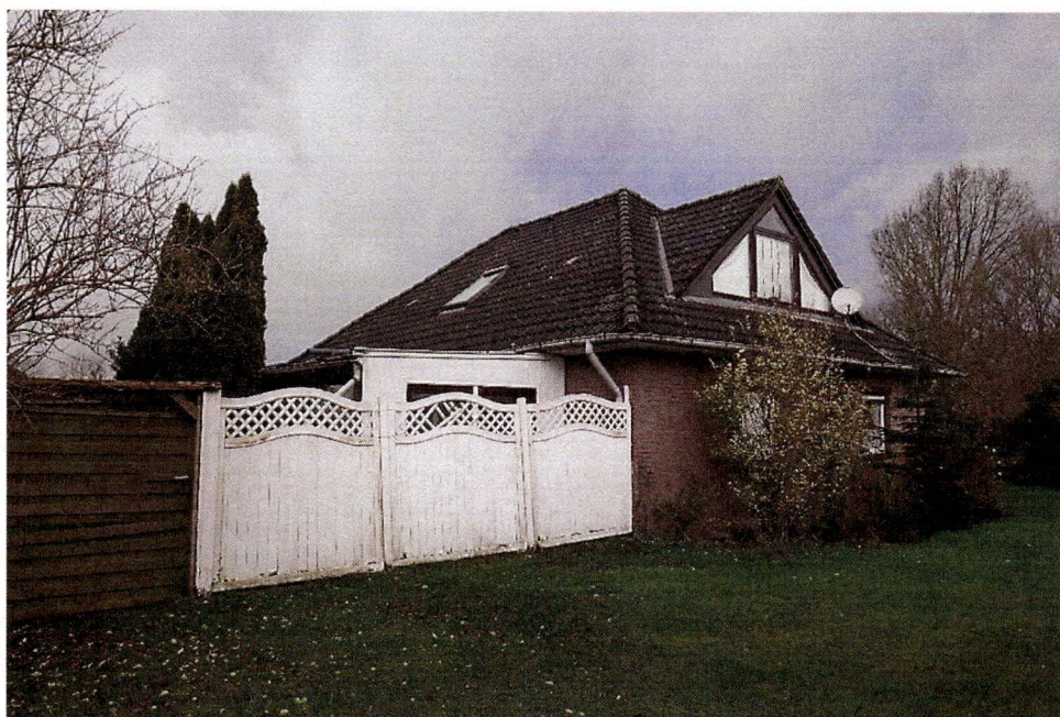
Bild 3: Ansicht aus südöstlicher Richtung
