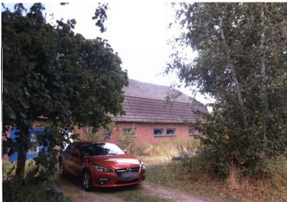
Ostansicht des Wohn- und Geschäftshauses
