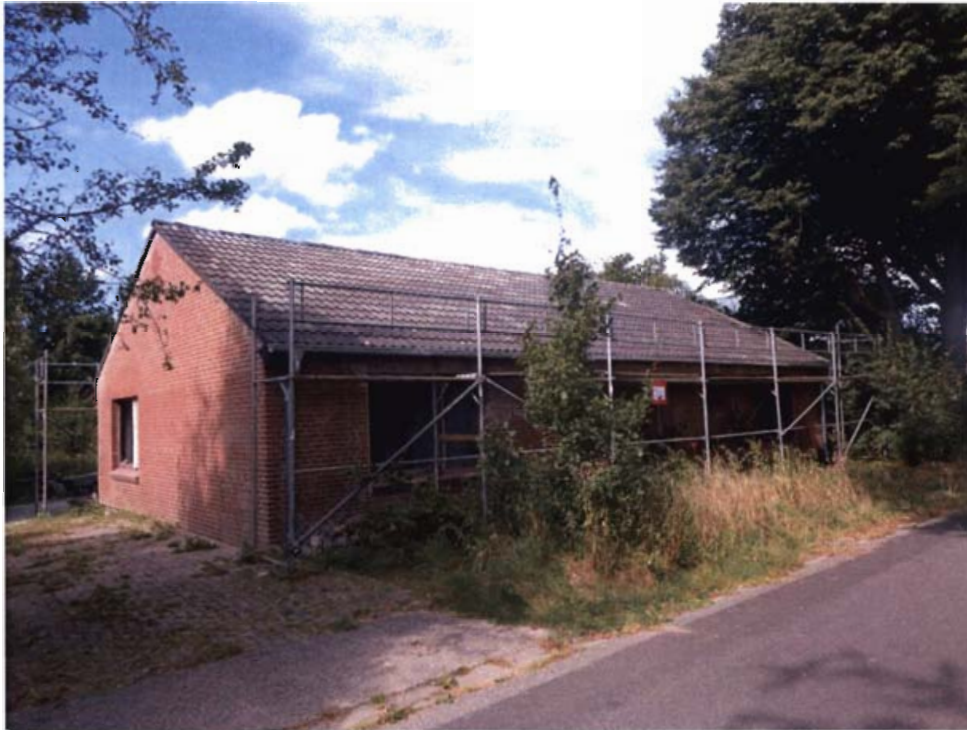
Südostansicht des Nebengebäudes
