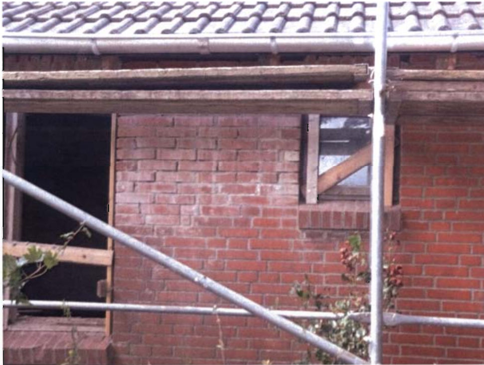
Detailansicht der Ostfassade des Nebengebäudes
