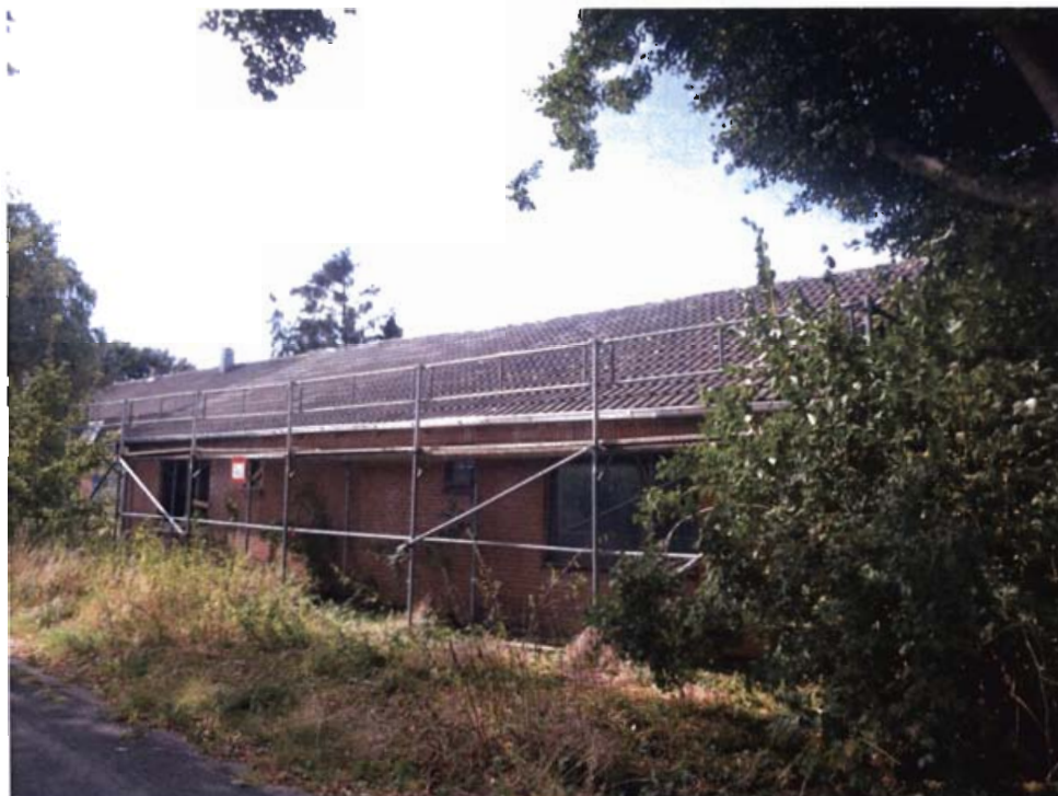
Ostansicht des Nebengebäudes
