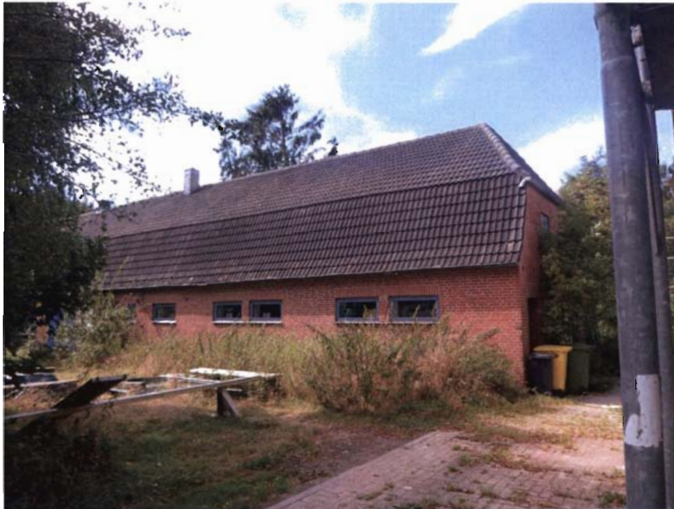
Nordostansicht des Wohn- und Geschäftshauses
