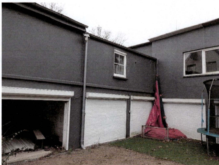
Bild 26: Büro und Garage 1 gartenseitig mit darunter liegenden Garagen
