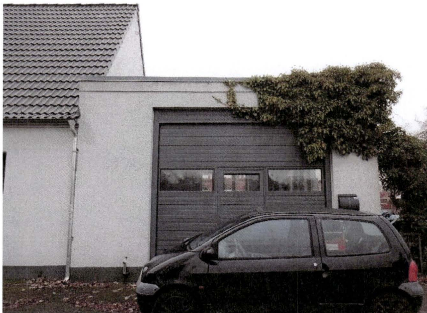
Bild 16: Halle 2 straßenseitig (Ostansicht)
