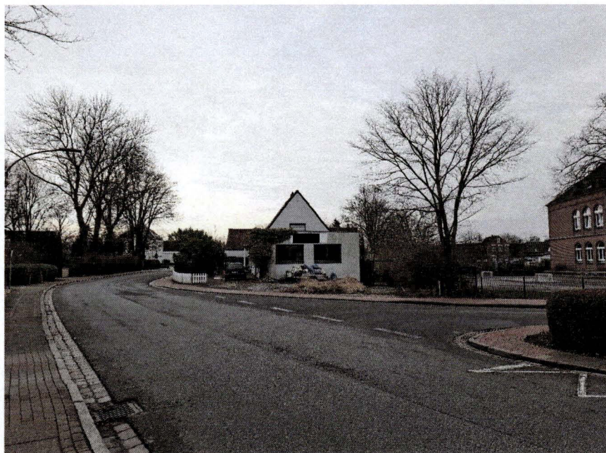
Bild 2: Straßenansicht Nordwestseite (im Vordergrund Halle 2)
