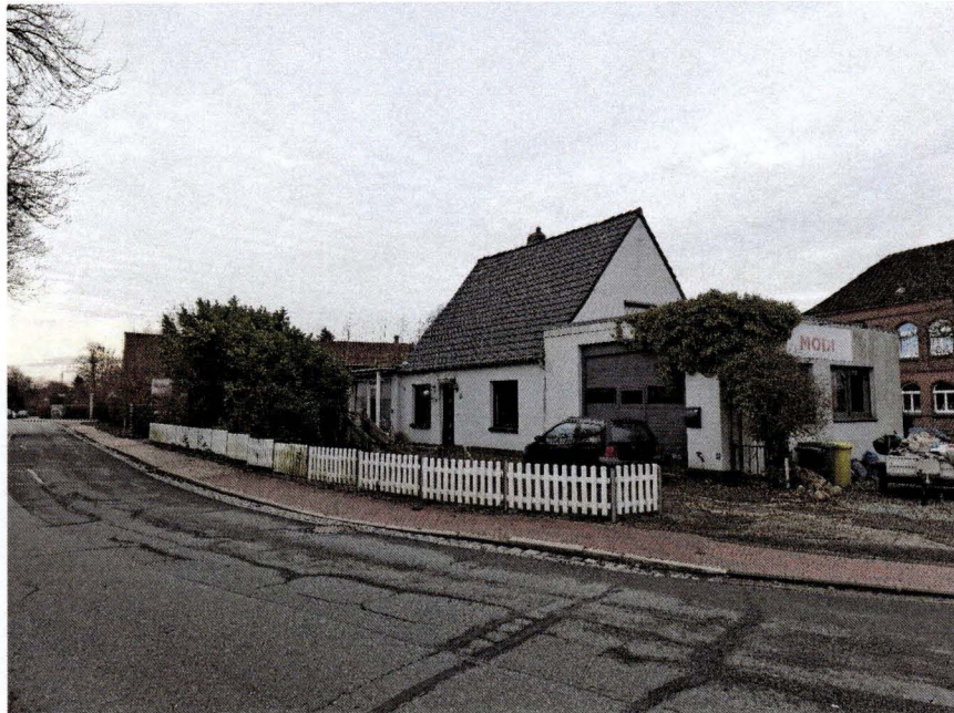
Bild 1: Straßenansicht Nordseite (Halle 2, Wohnhaus)
