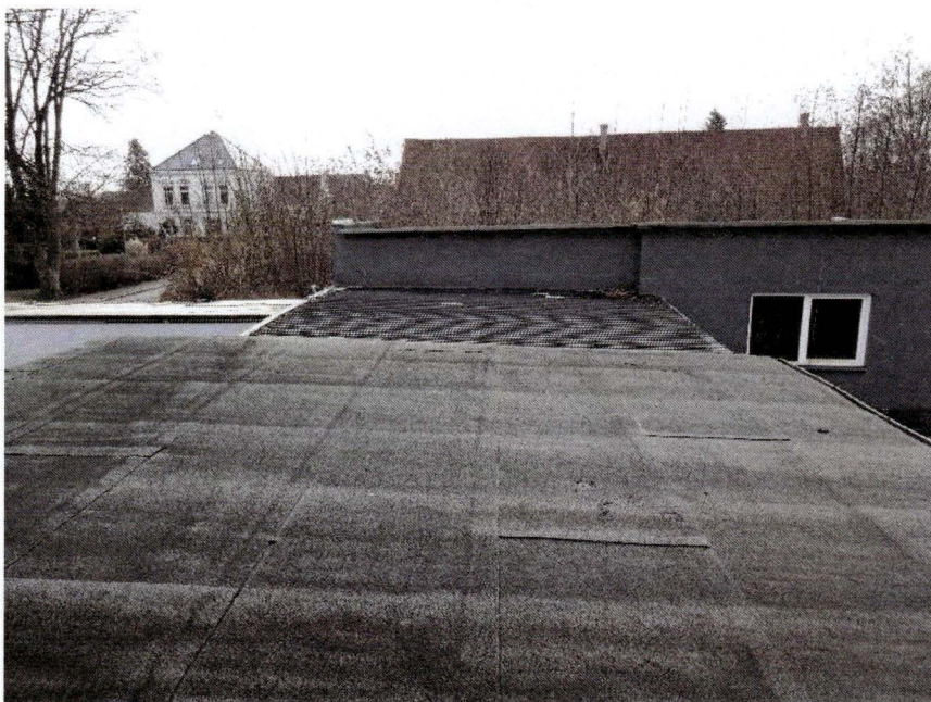
Bild 30: Dächer Büro und Garage 1 (aus dem Dachgeschoss des Wohnhauses heraus aufgenommen)
