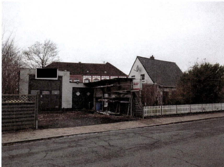
Bild 3: Straßenansicht Ostseite (Halle 1, Garage 1, Büro, Wohnhaus)
