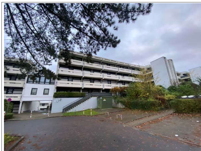
Foto 3: Ansicht von Westen
