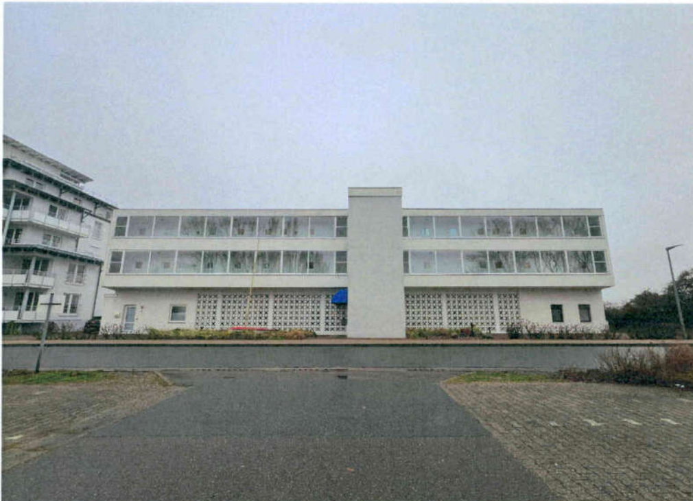
Foto 1) Ansicht Gesamtanlage von der Straße aus
