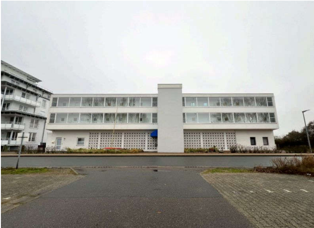
Foto 1) Ansicht Gesamtanlage von der Straße aus
