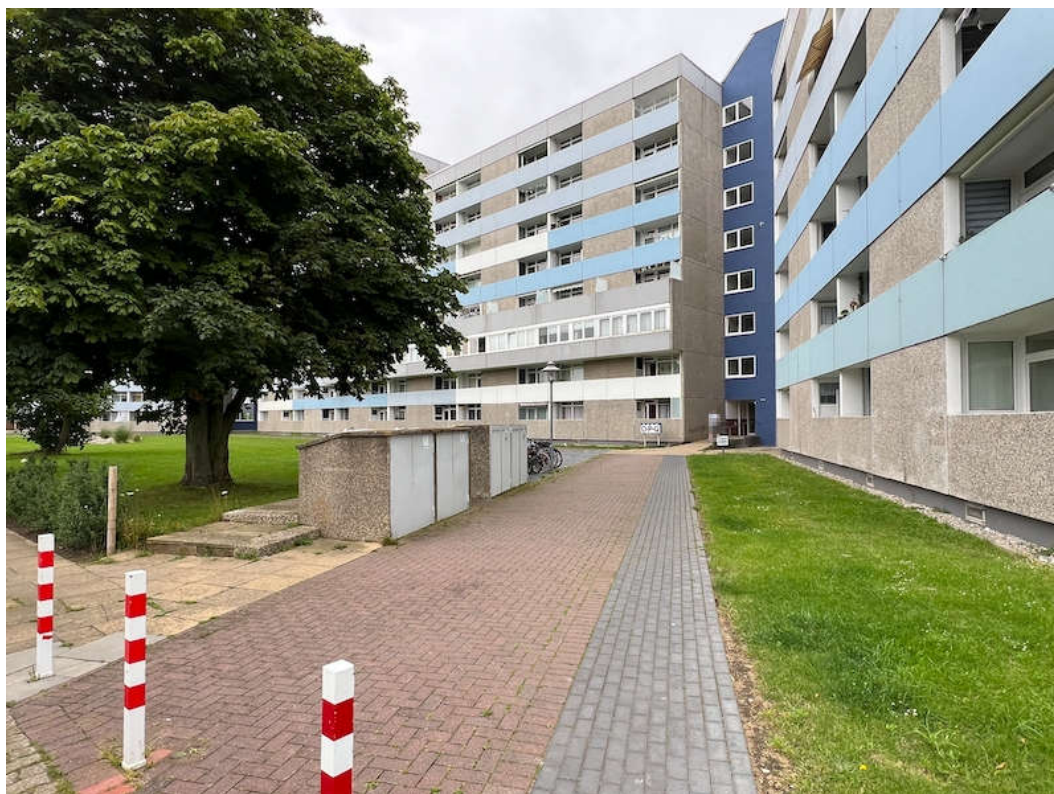
Foto 2) Zweiter Eingang von der Südseite
