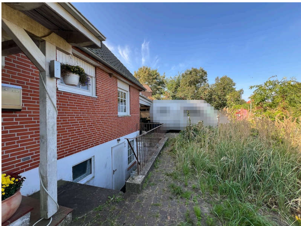
Foto 3) Ansicht Kelleraußentreppe und Carport
