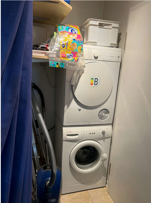
Foto 5) Waschmaschine und Trockner hinter der Tür
