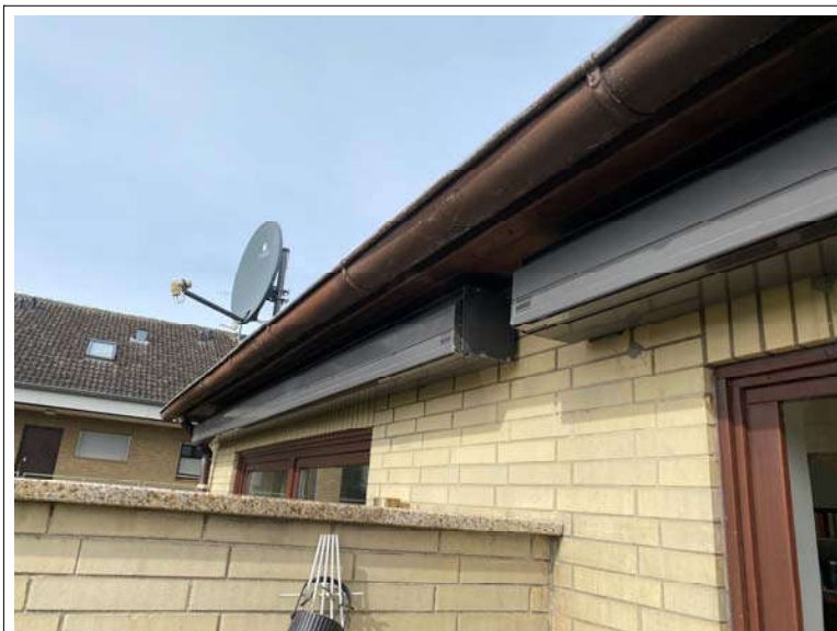
Foto 18: Dachunterschläge und Außenrollos
