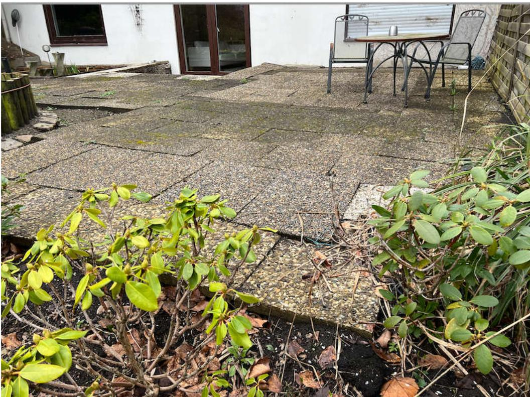
Foto 7) Beispiel zum Zustand der Plattenbeläge
