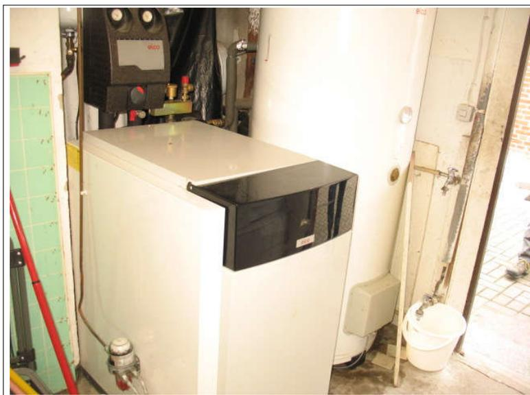
Foto 69: Nebengebäude, Heizungsanlage (Öl)
