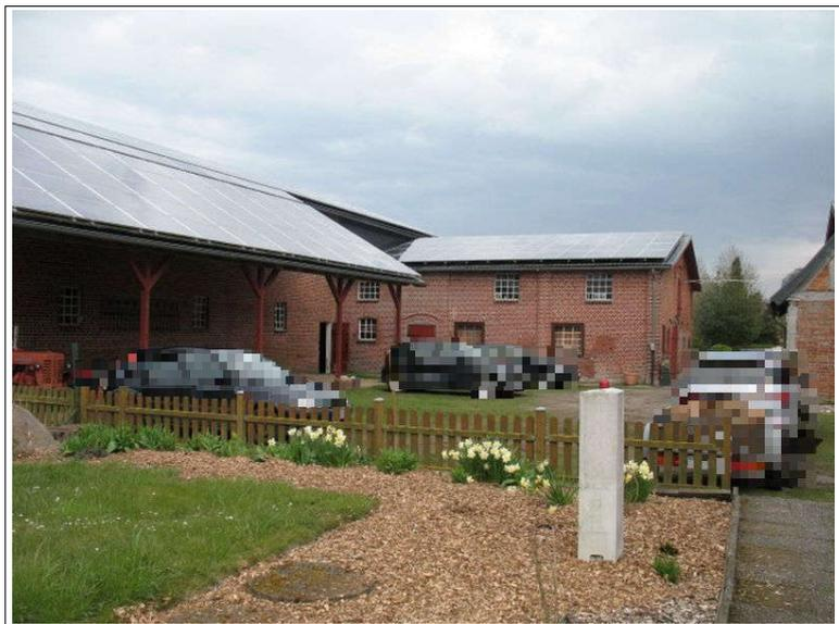
Foto 51: Anbau Schleppdach mit Photovoltaikanlage
