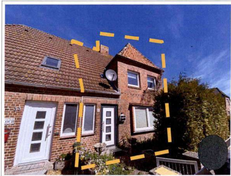
Foto 4: Straßenansicht von Süd-Osten
