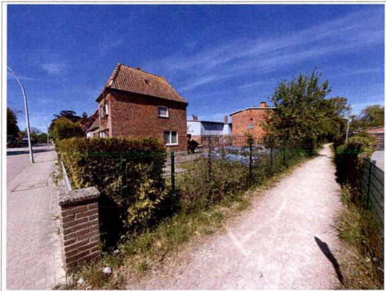
Foto 5: Ansicht von Osten
