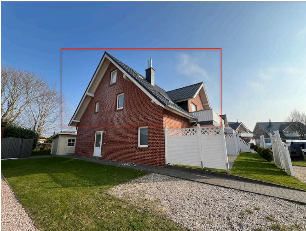
Foto 1) Ansicht Hauseingang und Stellplatz (Kies)
