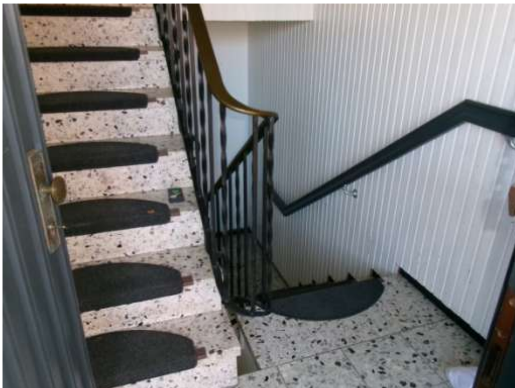
Rückwärtiger Gebäudeteil – Eingangsflur (Treppenhaus)
