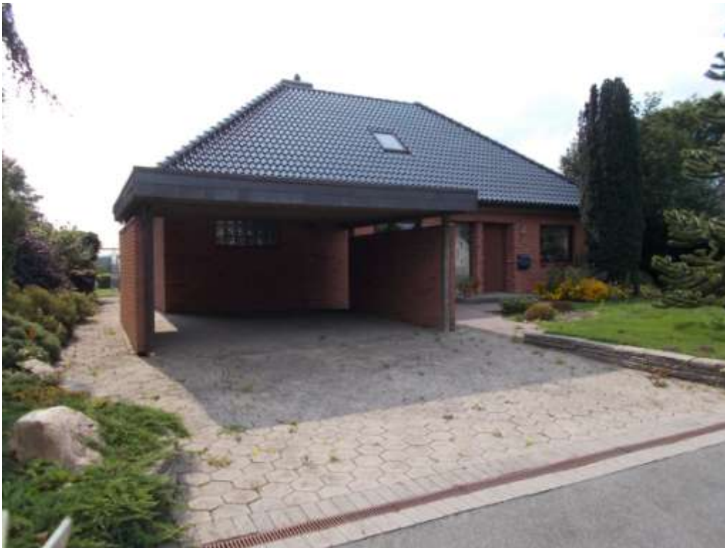
Straßenansicht von Nord-Osten
