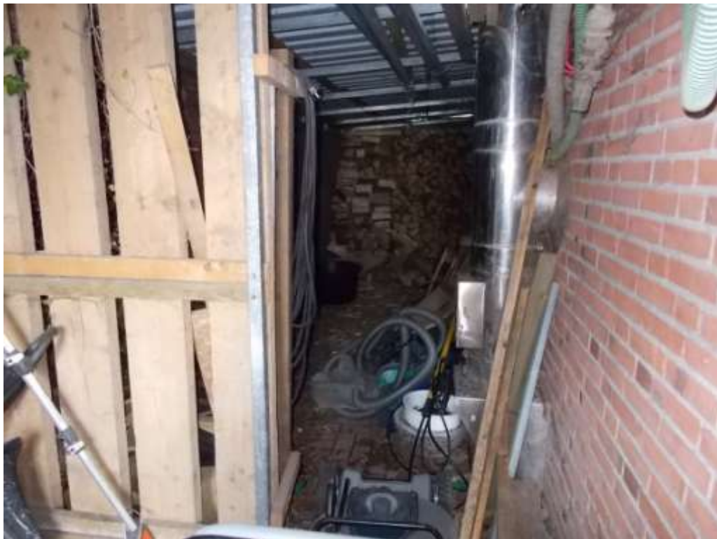
Holzschuppen an der nordwestlichen Fassade
