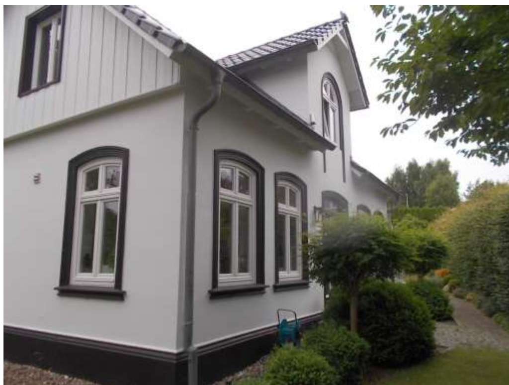
Westliche Fassade mit Eingangsbereich
