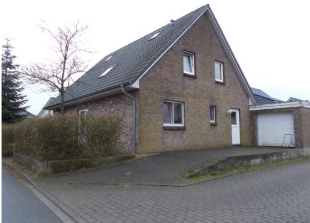
Straßenansicht von Nord-Westen
