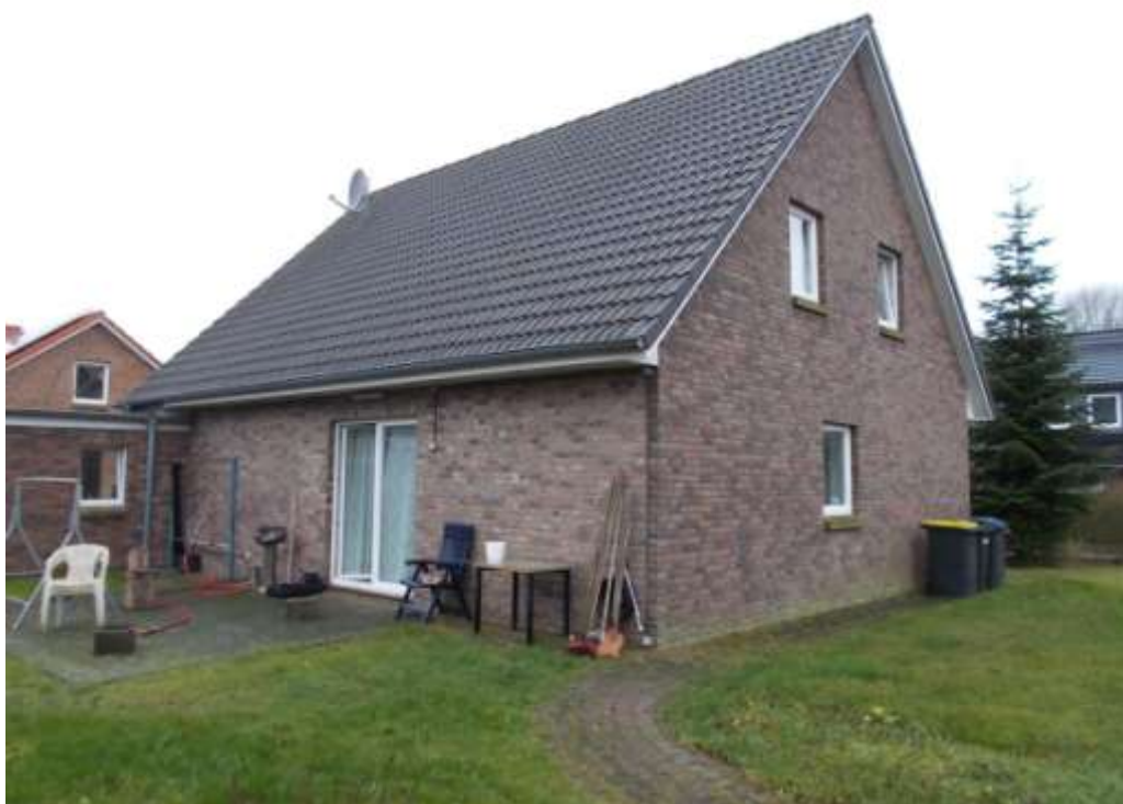
Ansicht von Süd-Osten
