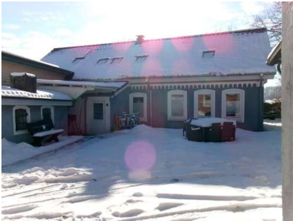
Hofansicht von Norden
