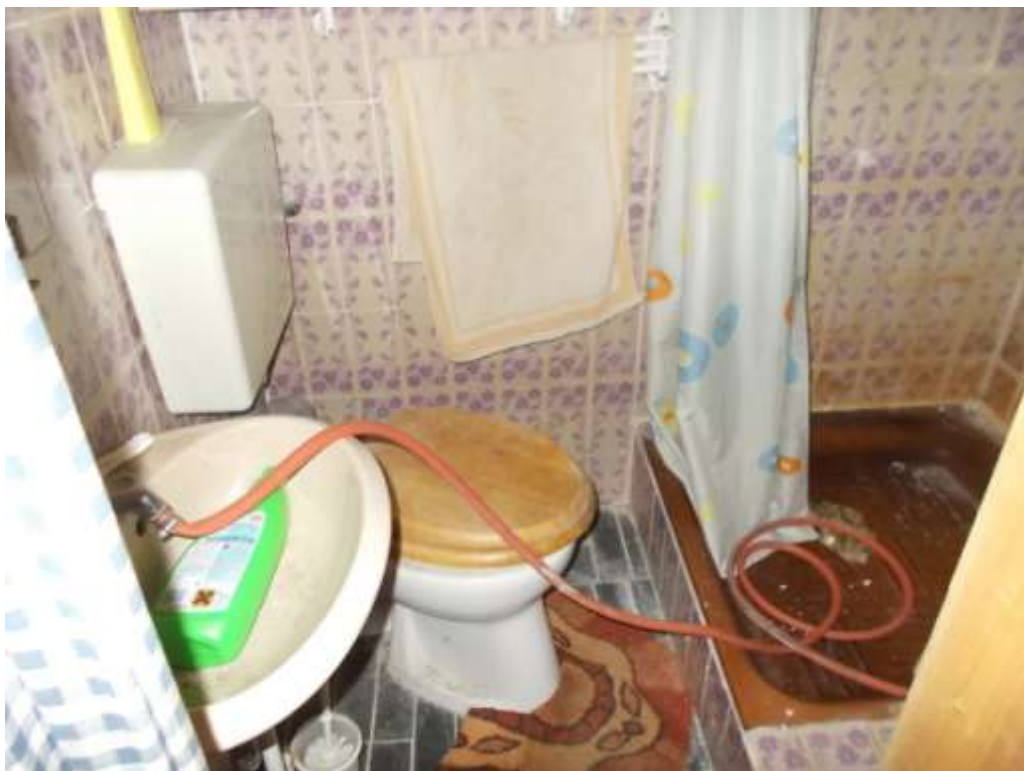
KG: Vom Flurbereich abgetrenntes Bad
