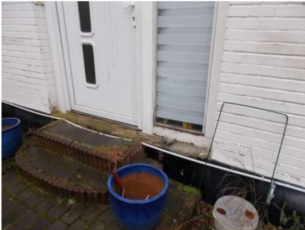
Eingangssituation an der östlichen Fassade
