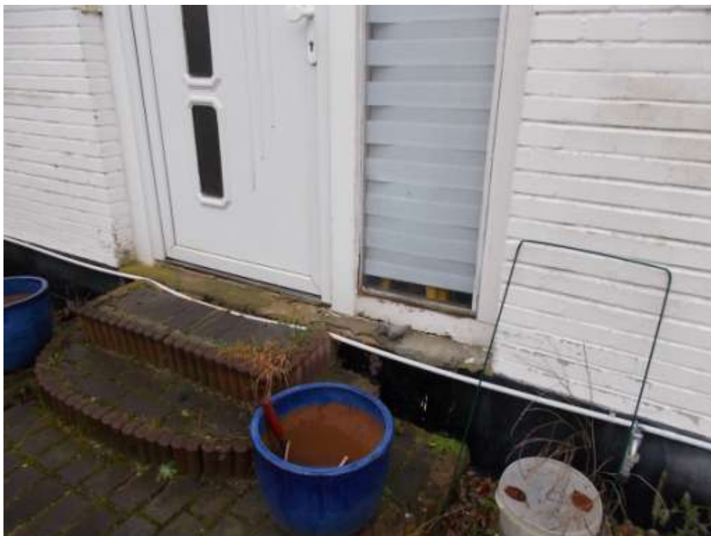
Eingangssituation an der östlichen Fassade
