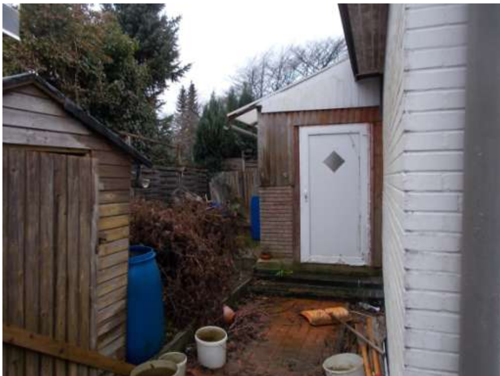
Terrassenüberdachung an der westlichen Fassade
