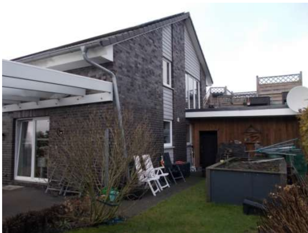
Nordöstlicher Giebel mit Blick auf die Garage
